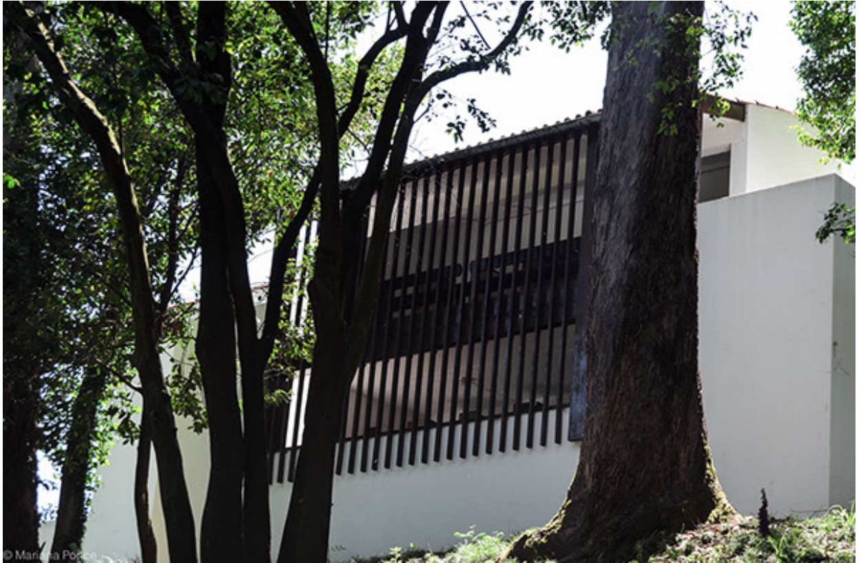
Figura 30 – Entradas de luz para os vestiários da Piscina da Quinta – Notamos a ligação visual entre o ripado de madeira e os troncos que rodeiam.
