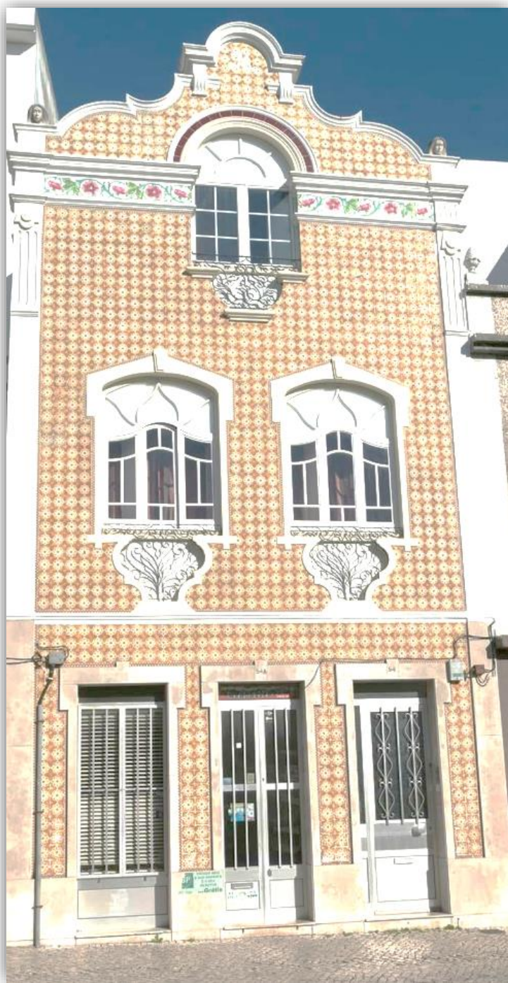
Fig. nº 5 - Residência do construtor civil Júlio Marques com intervenção no piso inferior
