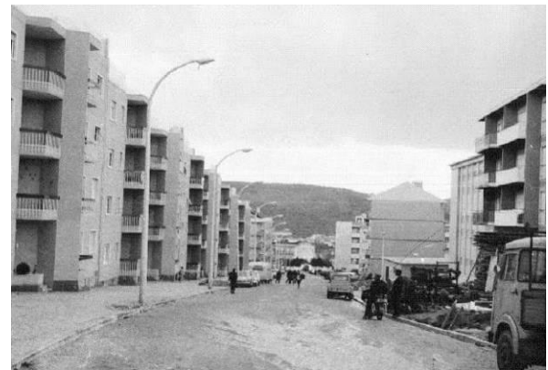
Fig. 15 – Avenida Augusto Abreu Lopes, Arquivo Municipal, 1968 (pensarodivelas, 2014)
