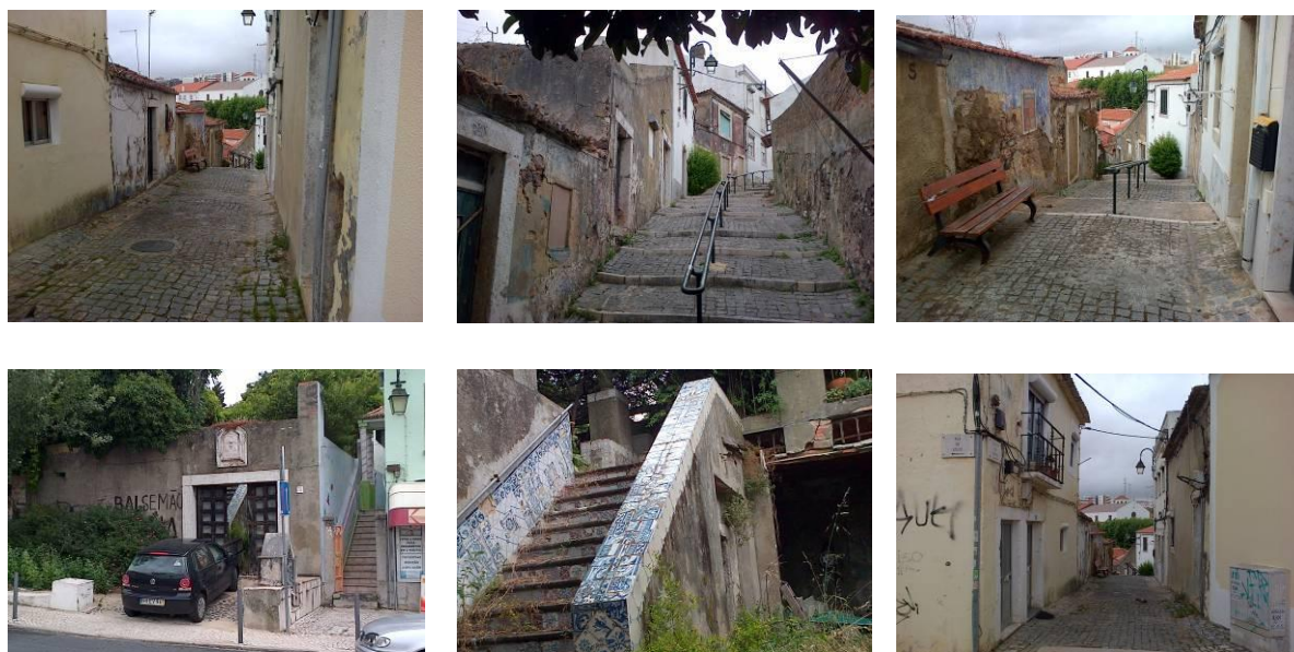
Figura 28 – Conjunto de imagens de edifícios degradados e devolutos no NHO, Odivelas. (Autor, 2014)
