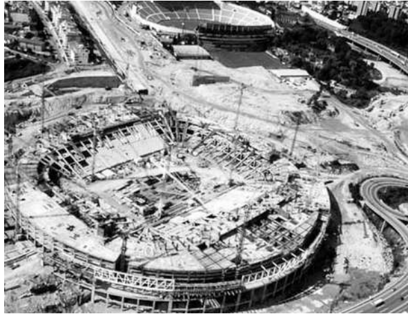
Figura 5.2 - Estádio das Antas e o novo estádio em construção
