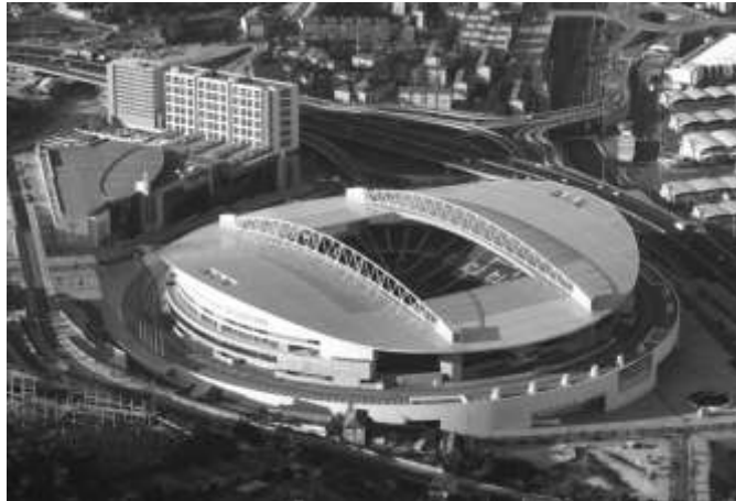
Figura 5.3 - Estádio do Dragão concluído
