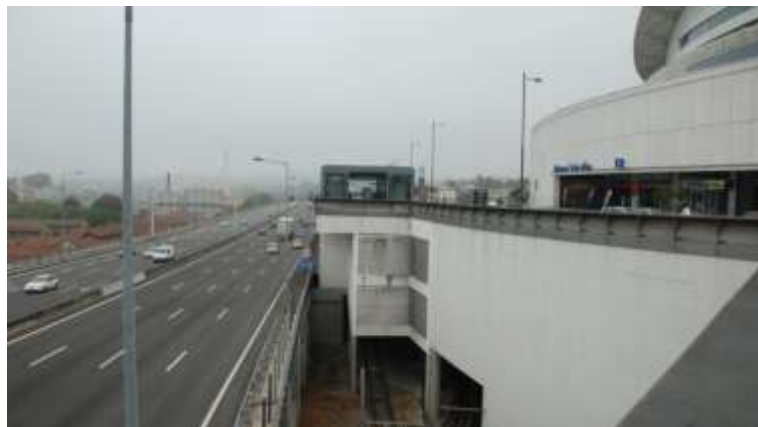
Figura 6.12 – VCI e estação de metro Fonte: O Autor
