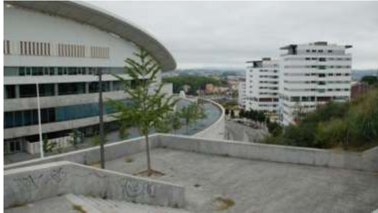
Figura 6.7 – Estádio do Dragão e Volumetria Implantada Fonte: O Autor
