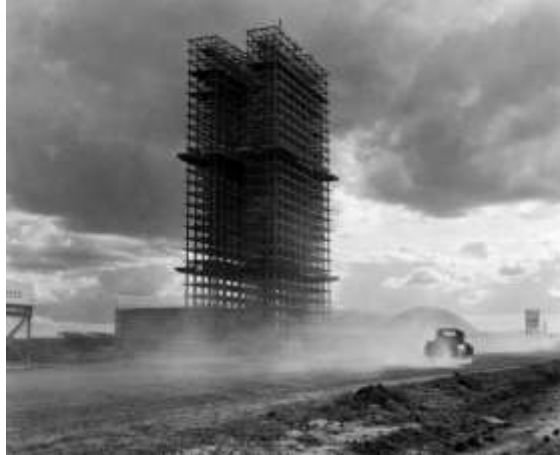
Figura 2.11 - Brasília (Brasil) em Construção
