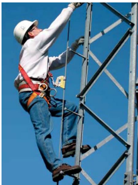
Figura 2.10 - Sistema anti-queda em escadas de torres de telecomunicações.
