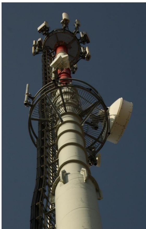
Figura 2.13 - Plataformas de acesso a vários níveis da torre.
