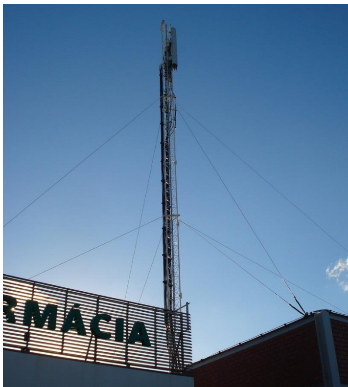
Figura 2.7 - Exemplo de uma torre treliçada espiada no topo de um edifício.
