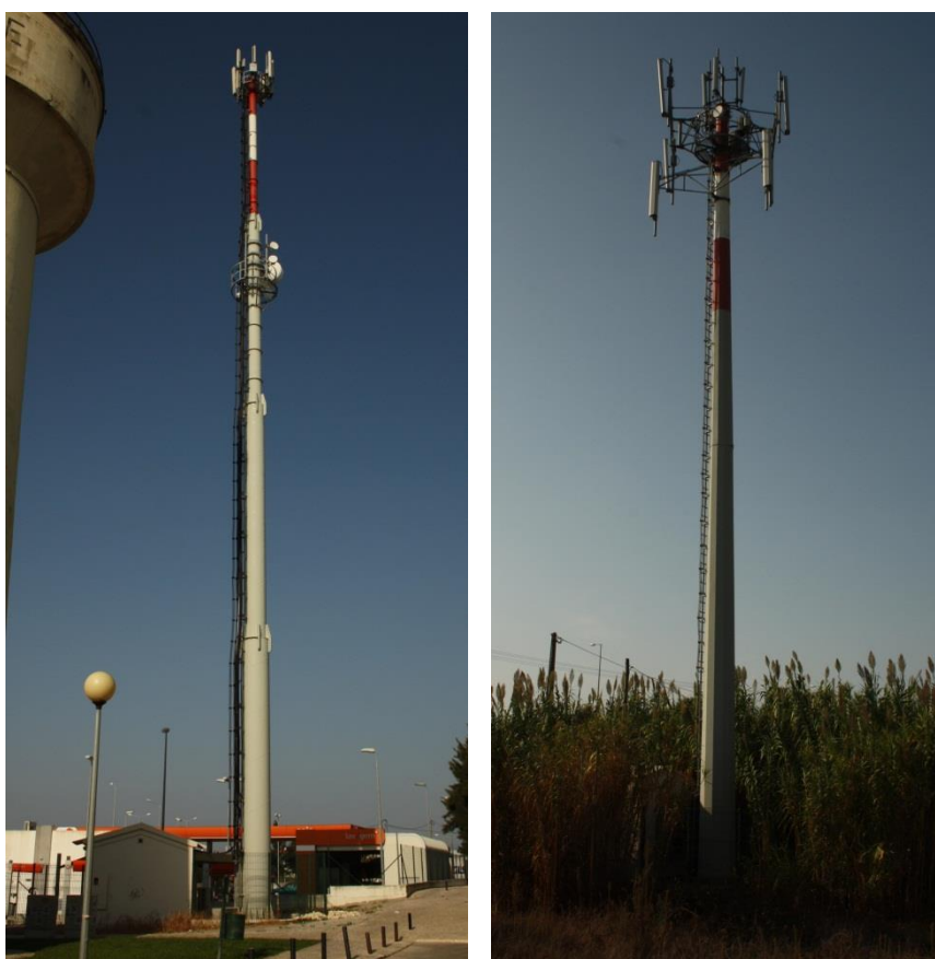
Figura 2.1 - Exemplos de dois tipos de torres de telecomunicações tubulares.
