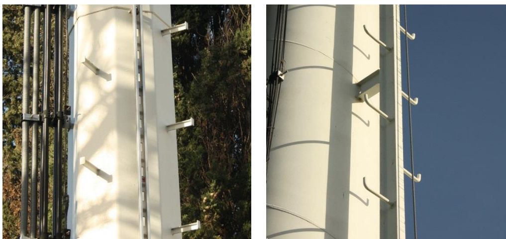
Figura 2.9 - Exemplos de alguns tipos de escadas em torres de telecomunicações.
