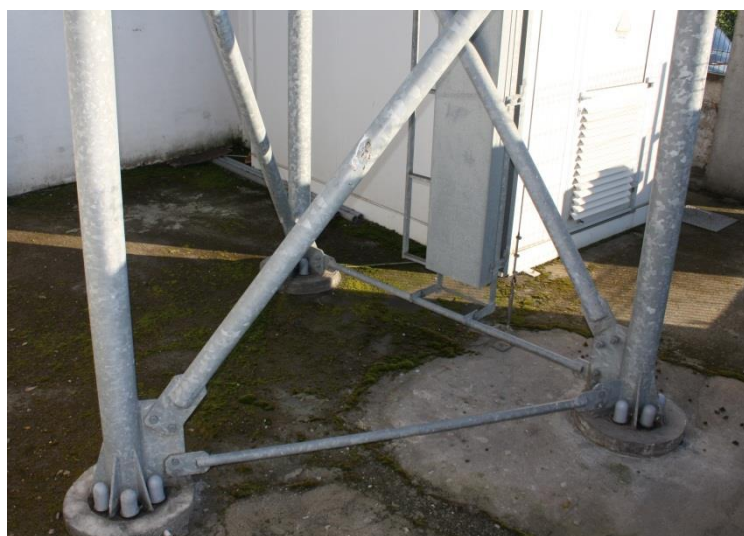
Figura 2.8 - Ligação de torre treliçada à fundação.
