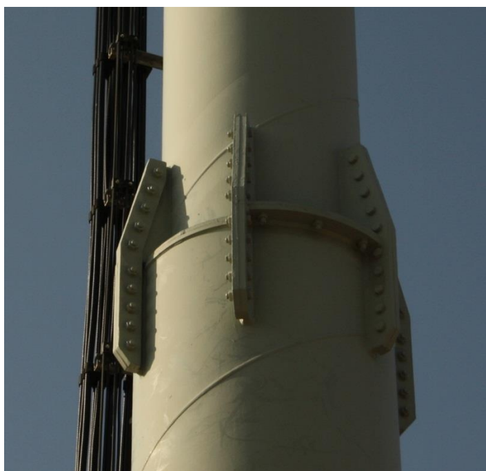
Figura 2.2 - Ligação entre troços de torres tubulares cilíndricas.
