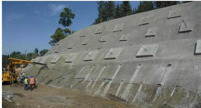
Figura 18 – Betão projetado alienado a cabos para a contenção de terras
