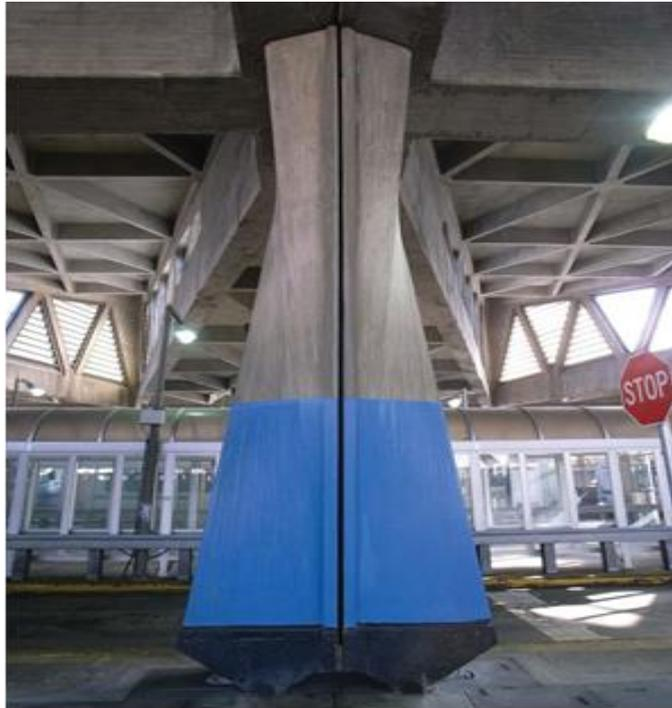
Figura 47 - Pino de aço duplo na parte inferior da coluna central na Estação Rodoviária George Washington em Manhattan
