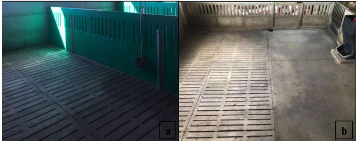
Figura 19. (a) Piso em grelha total; (b) Piso em grelha parcial (Original da autora).
