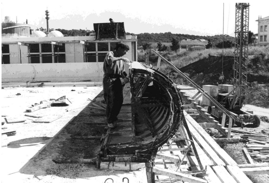
Figura 54 – Peças semicirculares na cobertura betonadas em obra, 1975-1980
