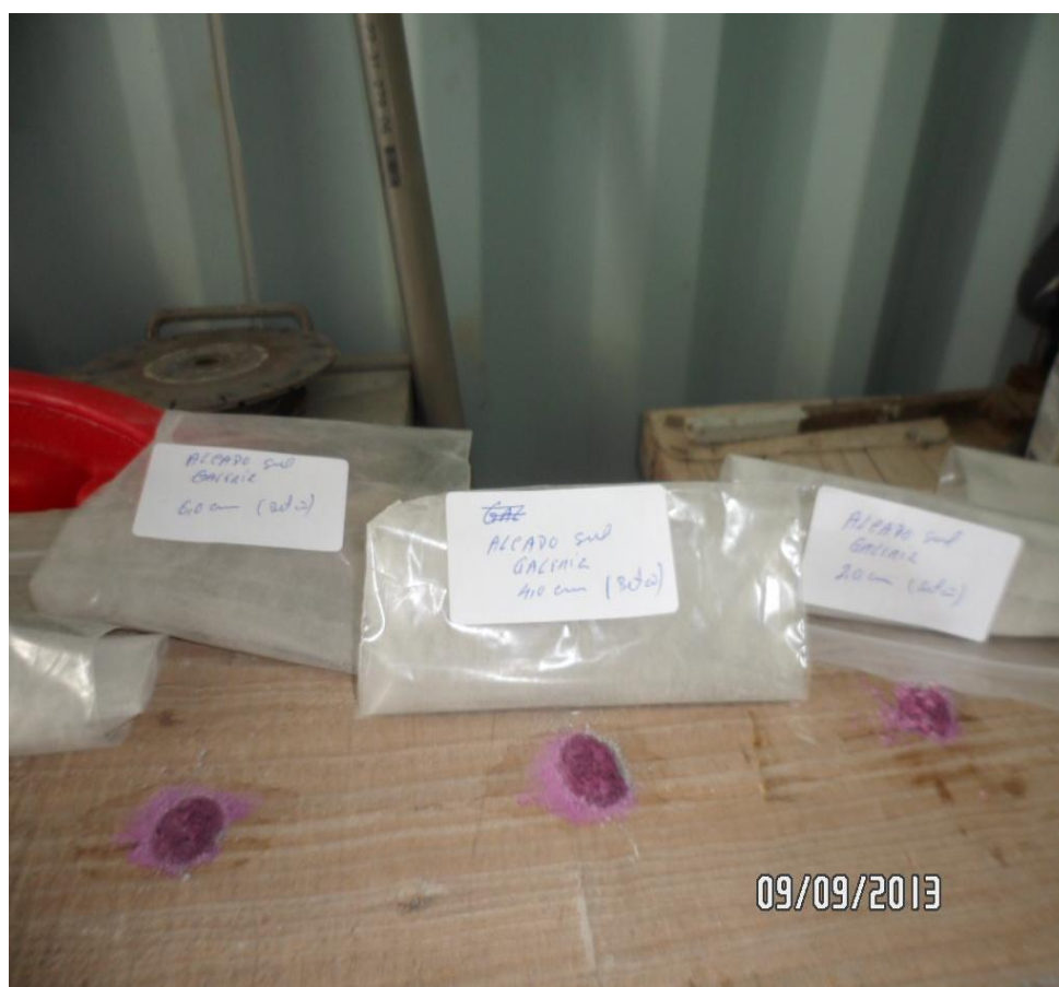
Figura 48 – Ensaio de fenolftaleína em várias partes da fachada ‘Alçado Sul Galeria’, 2013
