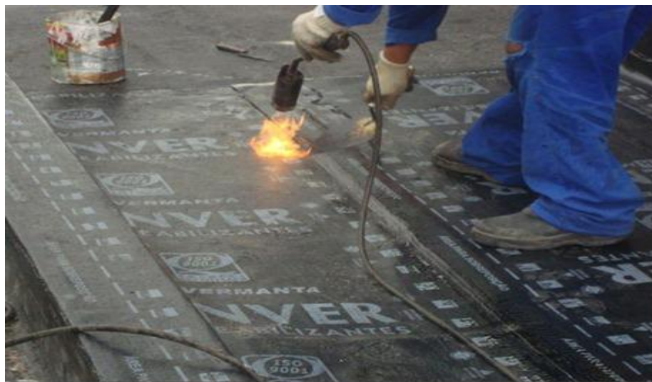
Figura 37 – Método de aplicação de membrana asfáltica
