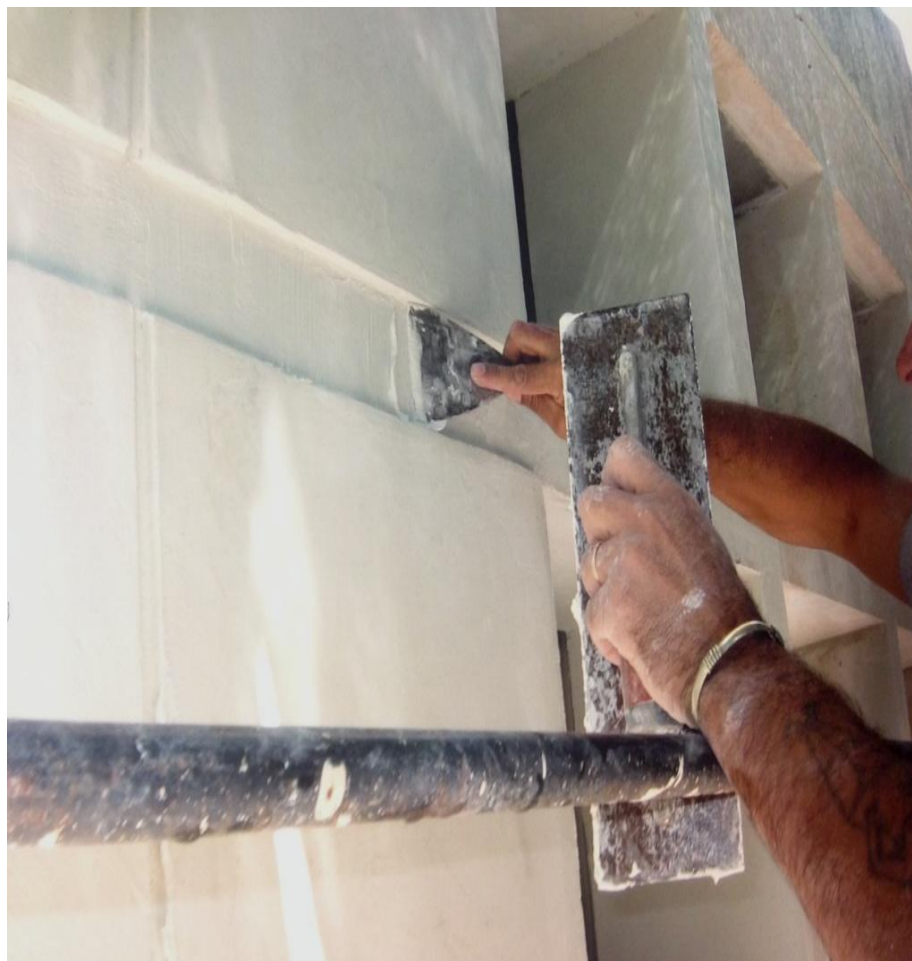
Figura 57 – Aplicação do revestimento de proteção nas fachadas, 2004
