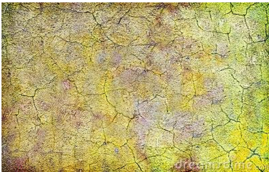
Figura 20 – Fendilhação tipo teia de aranha; pt.dreamstime.com
