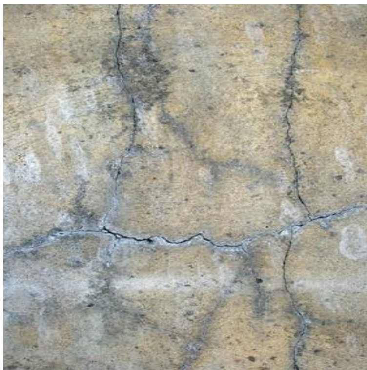
Figura 15 – Fendilhação devida a ciclos gelo-degelo; www.ehow.com.br
