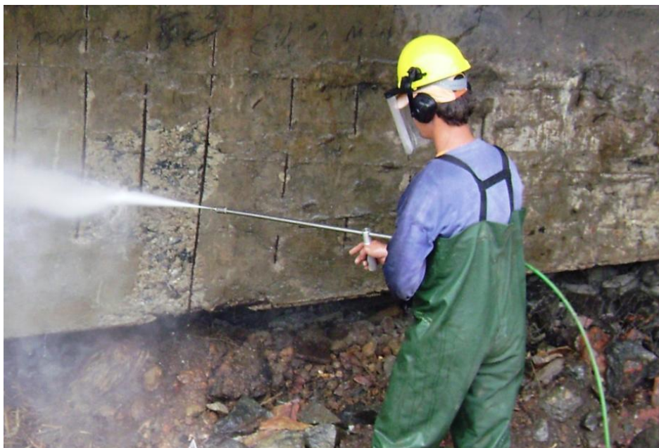
Figura 30 – Aplicação de jato de água para limpeza do betão; cidadesaopaulo.olx.com.br
