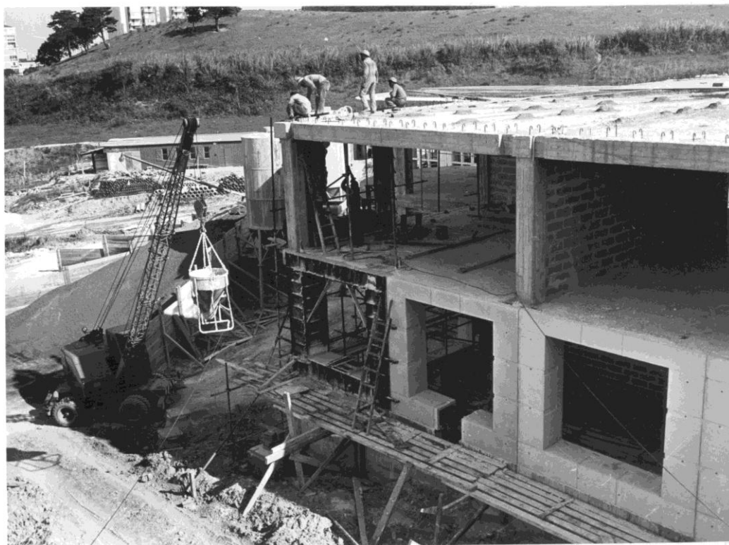
Figura 53 – Aspeto geral das fachadas dos módulos; painéis exteriores, 1975-1980
