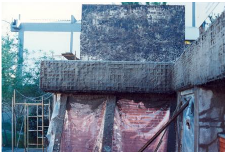
Figura 41 – Aplicação de malha de aço (ânodo) e argamassa de cimento na realcalinização do betão; www.stap.pt
