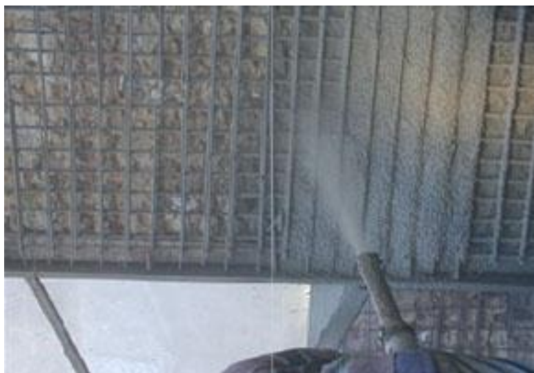
Figura 38 – Método de aplicação de microbetão; cm-viseu.pt
