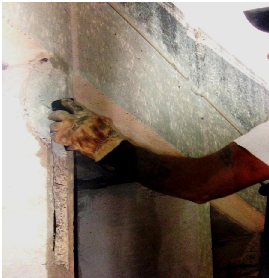
Figura 58 – Aplicação de argamassa de reparação, 2004
