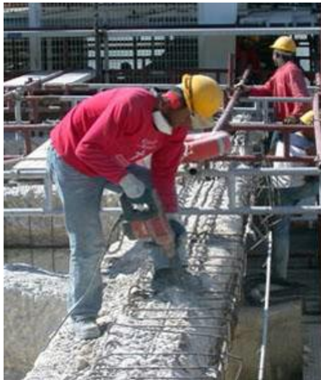
Figura 33 – Remoção de betão por esmagamento; construironline.dashofer.pt
