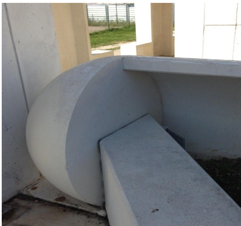
Figura 65 – Peças semicirculares na cobertura do módulo ‘C’ , 2013
