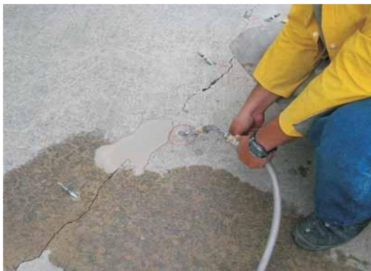
Figura 40 – Injeção de fissuras em laje; http://mundodaimpermeabilizacao.blogspot.pt/
