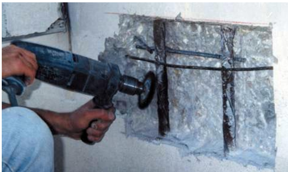
Figura 34 – Escovagem mecânica; construironline.dashofer.pt
