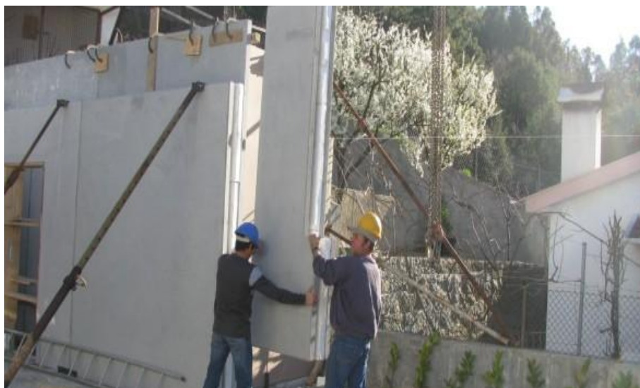
Figura 39 – Aplicação de painéis de betão prefabricado; www.farcimar.pt
