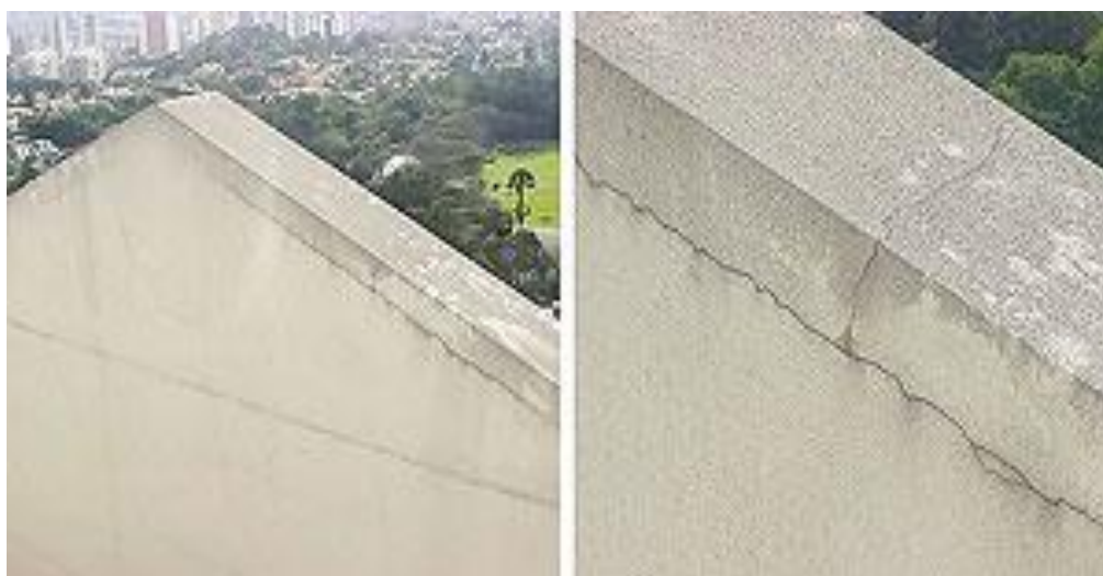
Figura 17 – Fendilhação devida à ação térmica; emconstrucao10.blogspot.com
