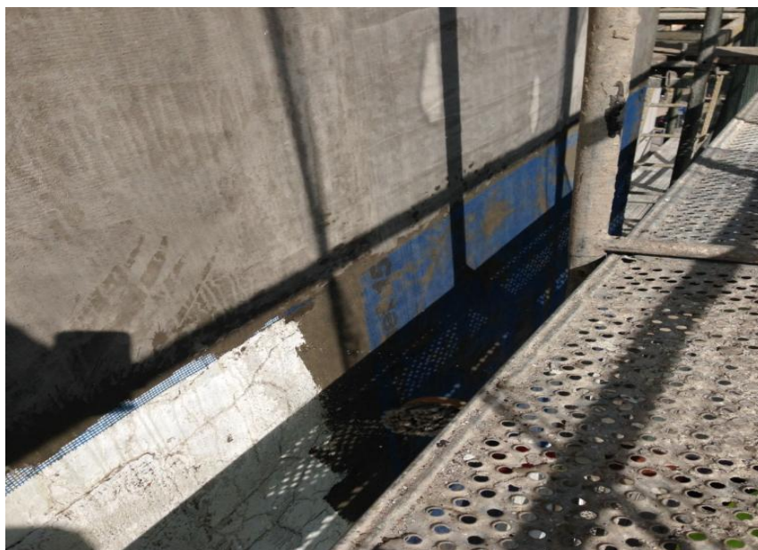
Figura 51 – Aplicação de argamassa cimentícia e rede de fibra de vidro em fachada, 2013
