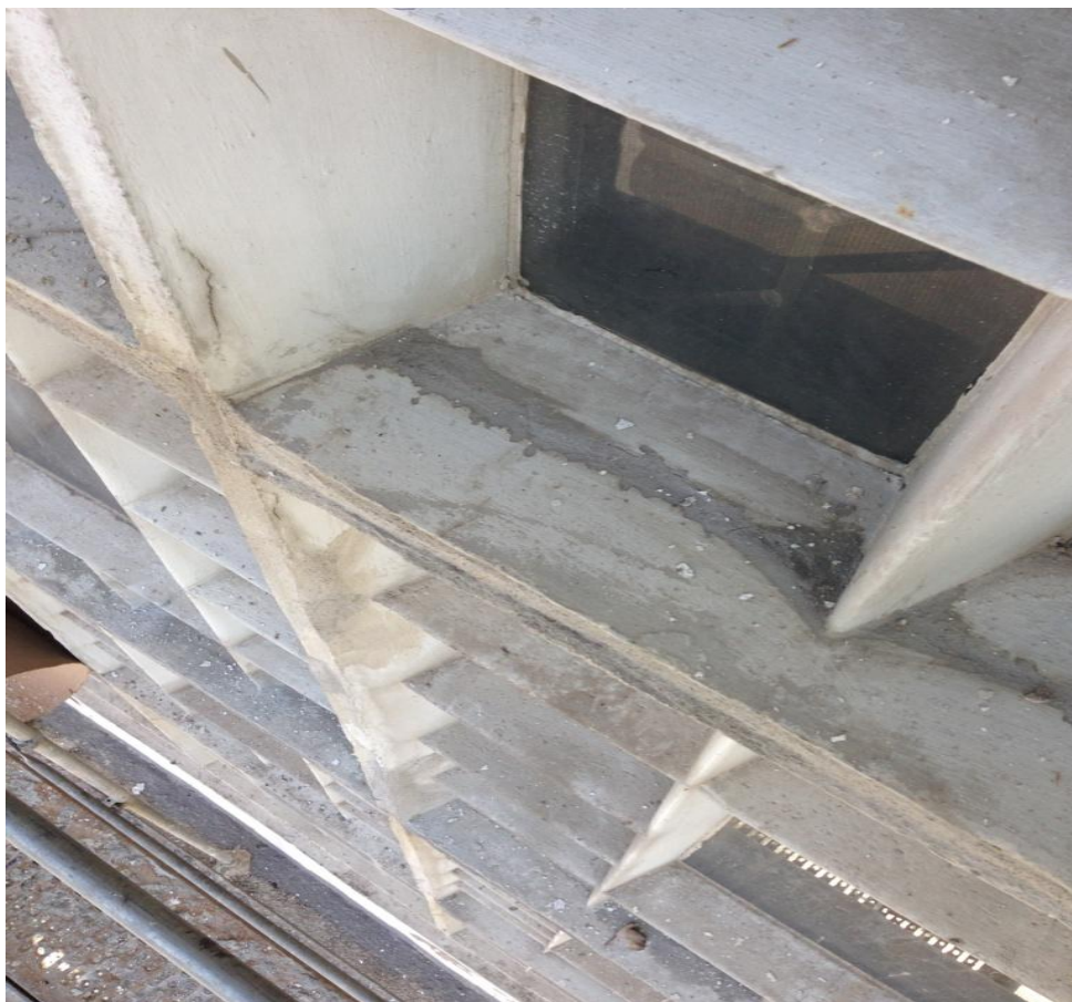
Figura 50 – Reparação de fissuras em painéis de fachada, 2013
