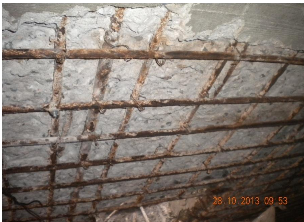
Figura 45 – Limpeza a jato de alta pressão nas zonas delaminadas, 2013
