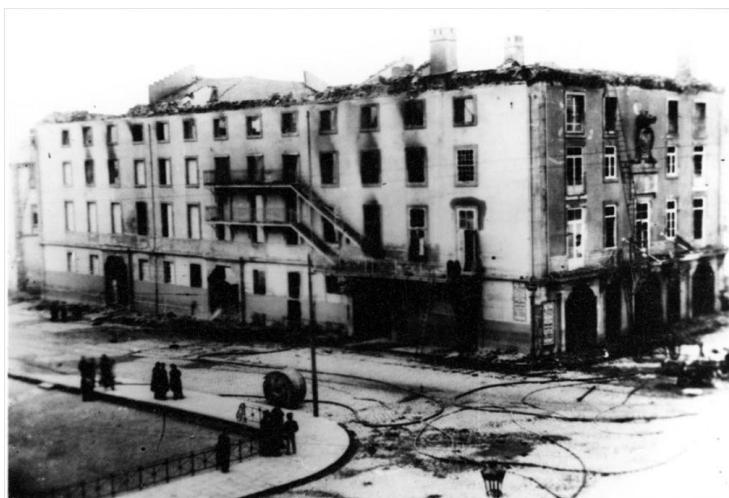
Figura 27 – Real Teatro de São João depois do incêndio. Acedido Abril 23, 2015 em http://gisaweb.cm-porto.pt/units-of-description/documents/49786/?q=TEATRO+SAO+JOAO
