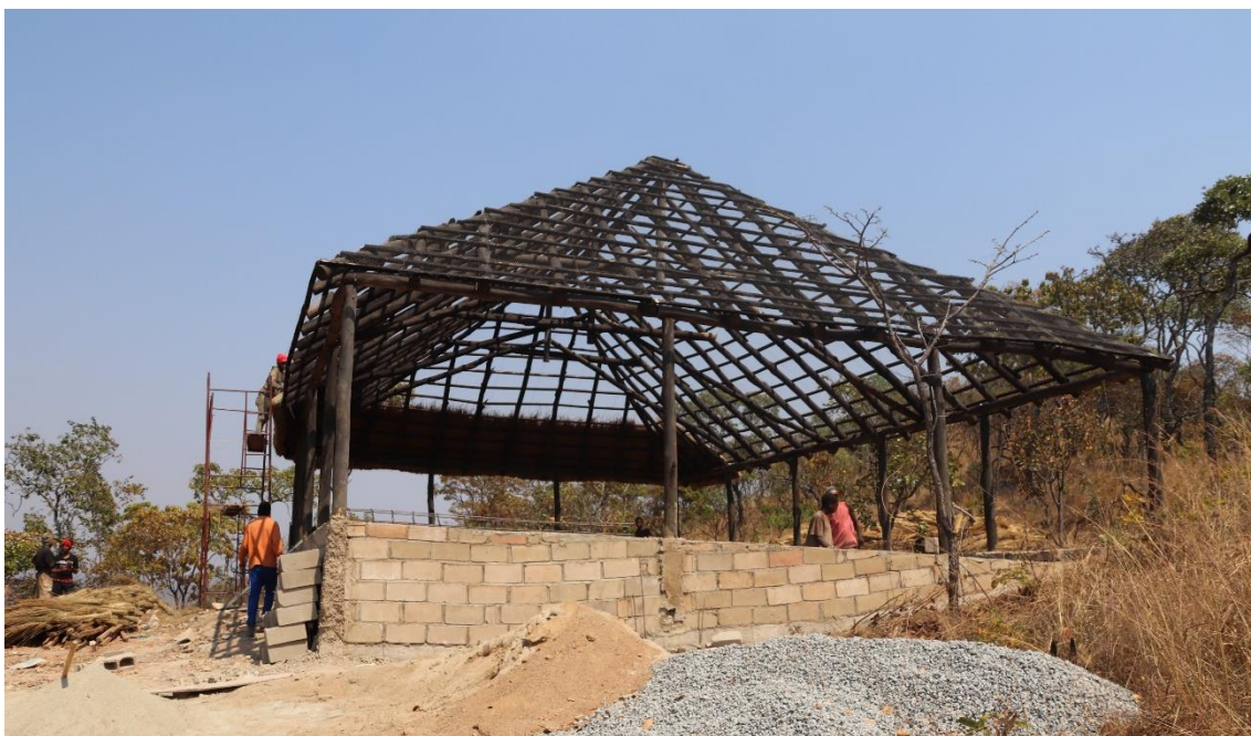
Figura 310- Estrutura de troncos de eucaliptos para a construção de um bangalô na aldeia Camela Amões, Huambo. Fonte: Arquivo da autora, 2019
