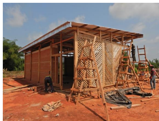
Figura 181- Construção da Escola/ Sala de aula de Okorase, Gana, Fonte: archDaily
