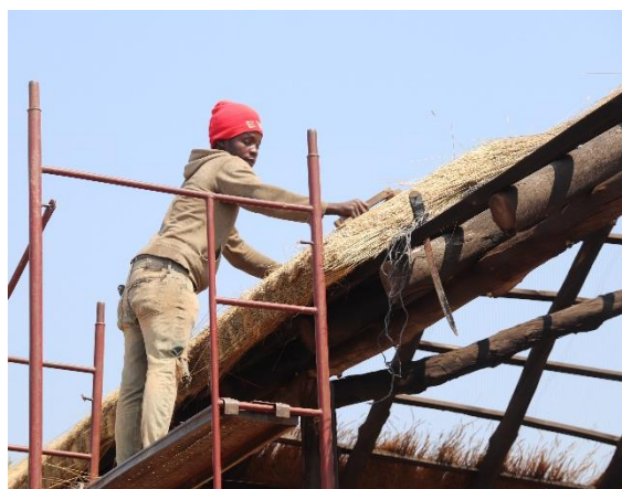
Figura 102- aplicação da cobertura de capim de uma das construções da Aldeia Camela Amões, Angola. Fonte: Arquivo da autora (2019)
