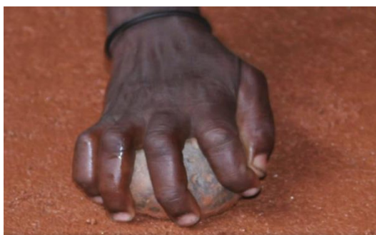
Figura 307- Compactação do solo com pedra para o piso de terra batida. Fonte: TED Talk
