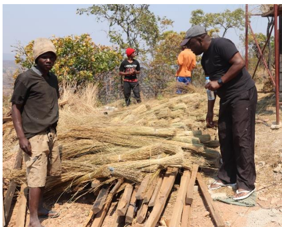
Figura 101- “Capim seco” antes da aplicação na cobertura de uma das construções da Aldeia Camela Amões, Angola. Fonte: Arquivo da autora (2019)
