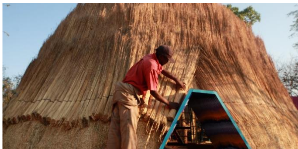
Figura 171-Aldeões na construção da cobertura do Jardim de infância do Zimbábue. Fonte: archdaily .
