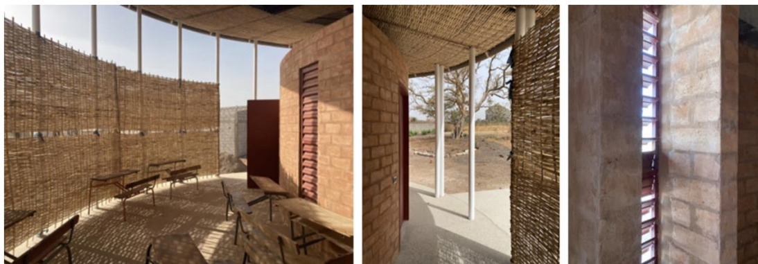
Figura 239- Ligação da Biblioteca escolar como exterior. Fonte: croixmariebourdon.fr
