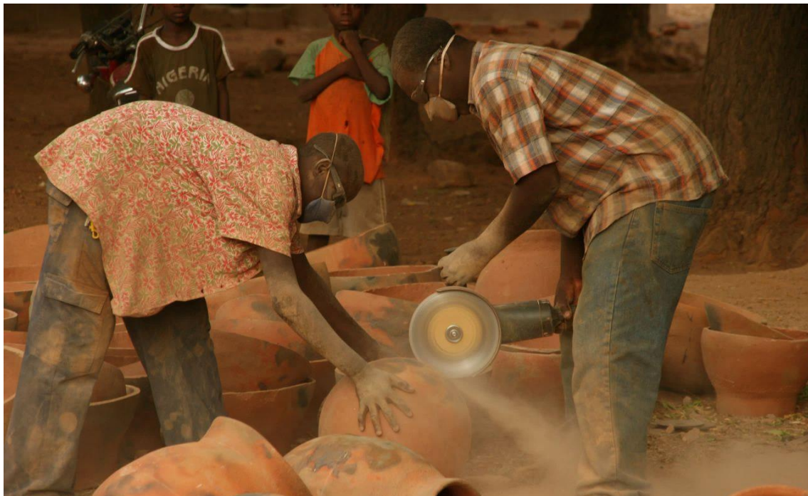
Figura 165- Moradores locais a cortarem as painéis de barro (usadas na construção do telhado da Biblioteca Escola Gando). Fonte: Kéré Architecture.
