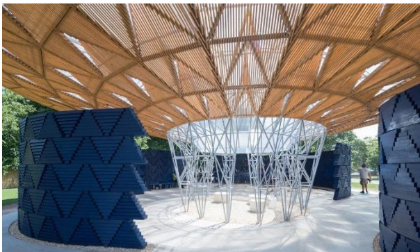
Figura 176- Serpentine Pavilion 2017, estrutura metálica no centro. Arquiteto: Francis Kéré. Fotografia Iwan Baan.
