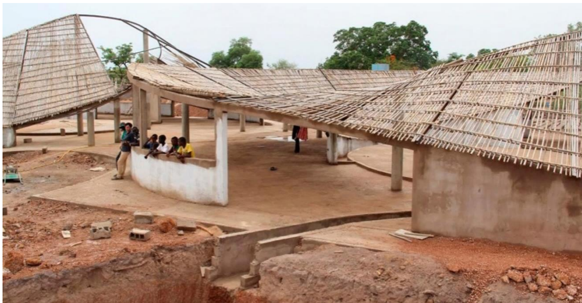
Figura 191-Construção do Centro Cultural Sinthian, Fonte: Toshiko Mori Architect
