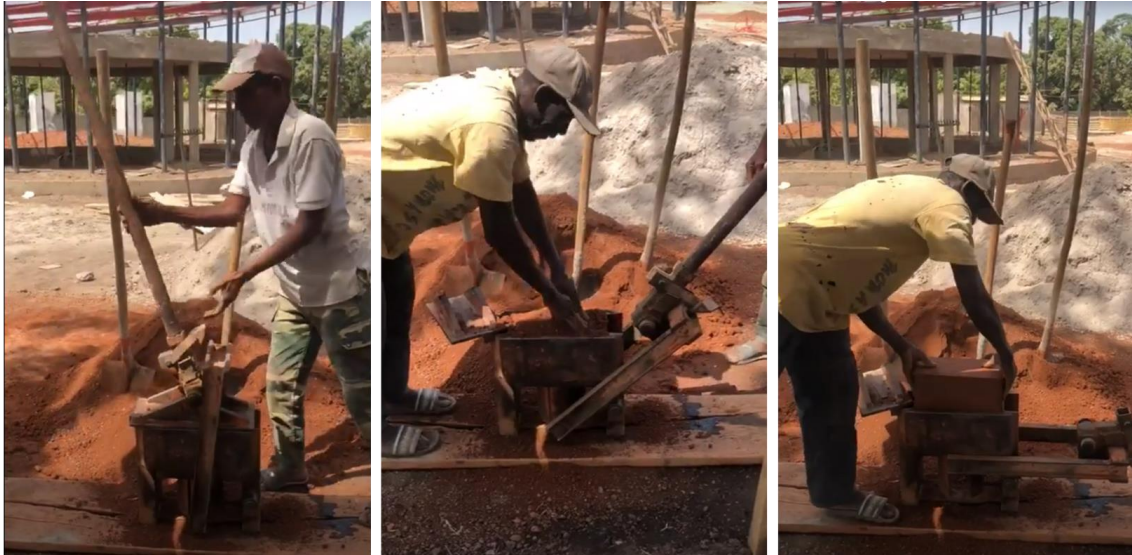
Figura 244- Moradores a trabalharem na fabricação de blocos para a construção da Biblioteca escolar Fonte: croixmariebourdon.fr
