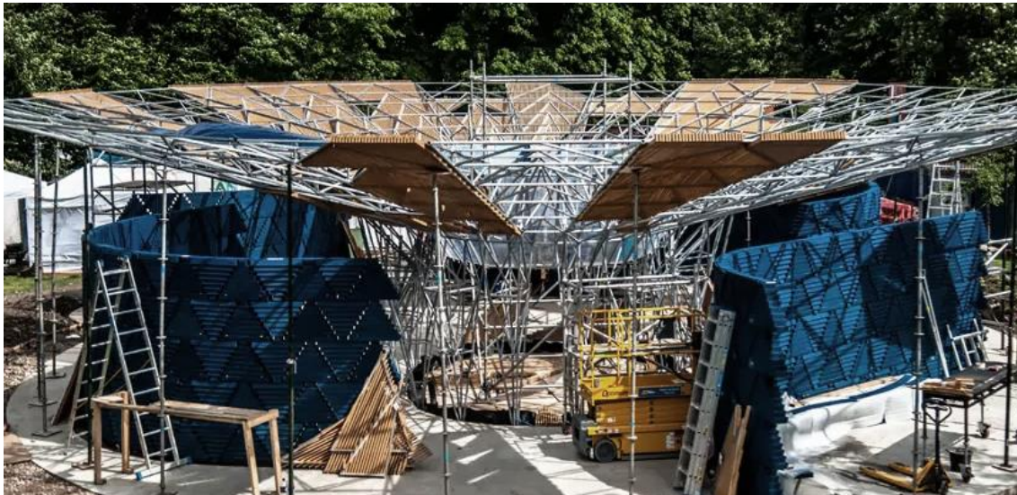
Figura 221- Construção do Serpentine Pavilion 2017, Francis Keré. Fonte: stageone.co
