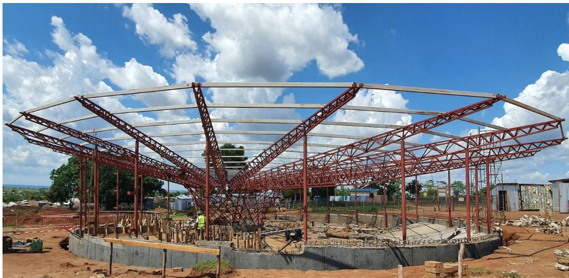
Figura 203- Construção do Centro de Música e Artes, Fonte: architecturetoday.co
