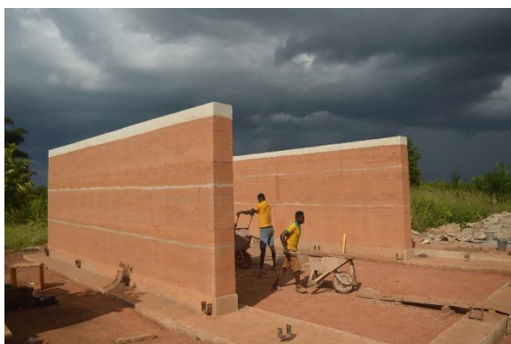
Figura 180- Construção da Escola/ Sala de aula de Okorase, Gana, Fonte: archDaily
