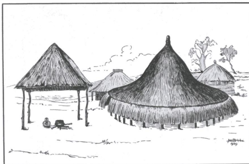
Teixeira de Sousa, Luau, soba Mucuzana, Celeiro nquila e cozinha e um txissambo de modelo luena (alpendrada para cozinha e trabalho doméstico). Esta construção é considerada, entre os próprios, muito útil e distinta. Diâmetro interior: 4 metros
