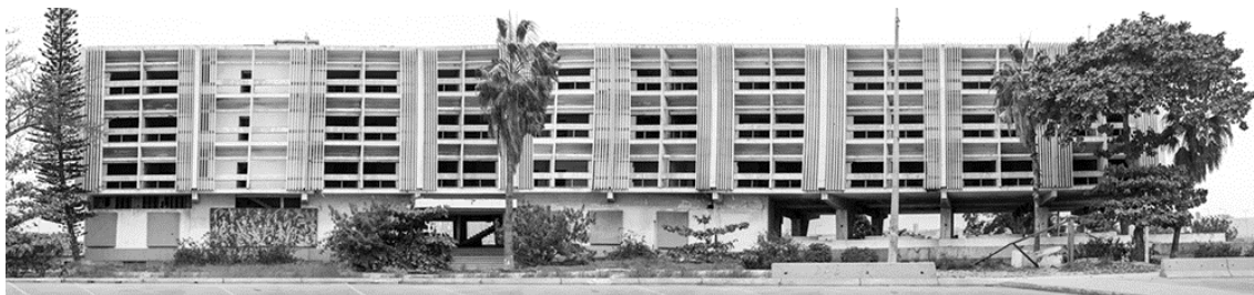
Figura 21-Hotel Panorama (Luanda) construído em 1961.Projetado por: Luís Garcia de Castilho e João Garcia de Castilho. Fonte: gulbenkian.pt
