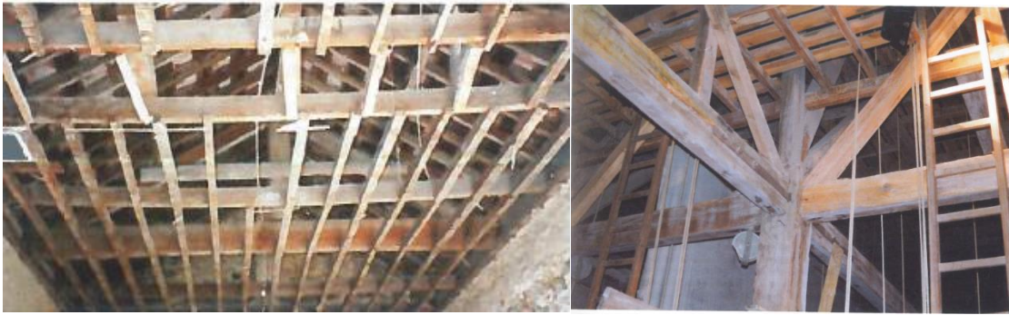
Figura 5 Cobertura com asna simples de duas vertentes
