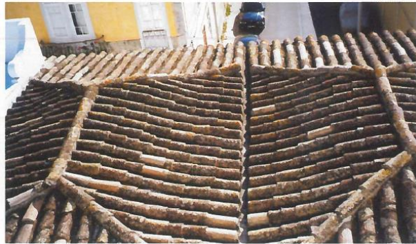
Figura 6 Cobertura de águas múltiplas
