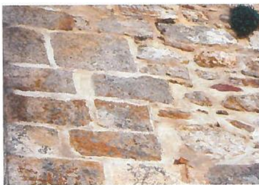
Figura 15 Blocos de pedra de boa qualidade e com perpianhos, em cunhal.
