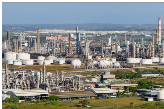
Figura VI.08 - Polo Petroquímico de Camaçari, Bahia 35
