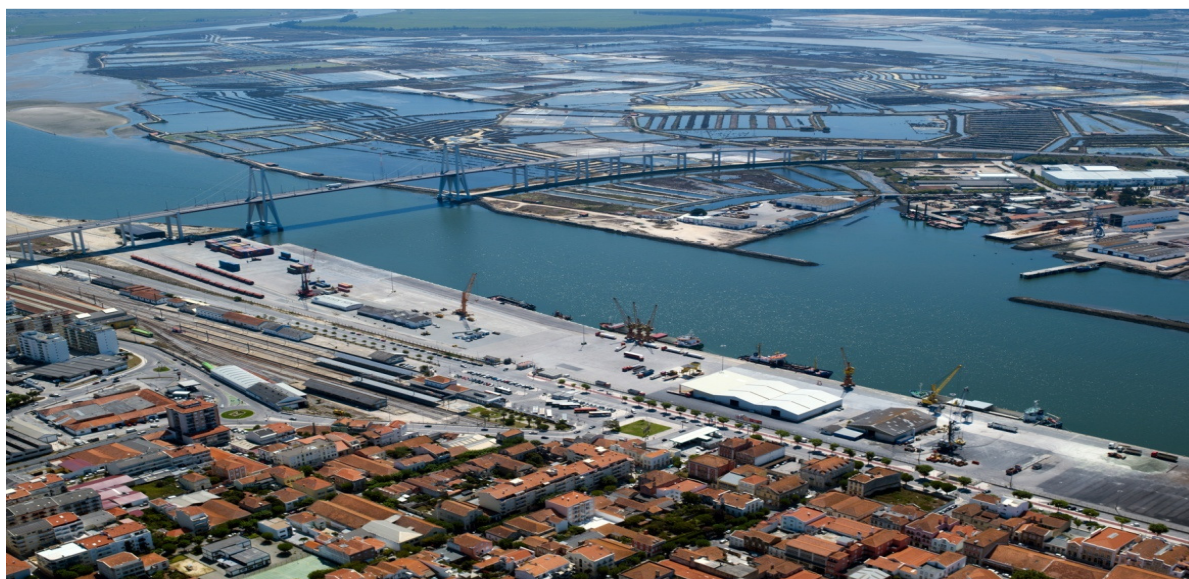
Figura 19 - Vista aérea do Porto de Figueira da Foz
