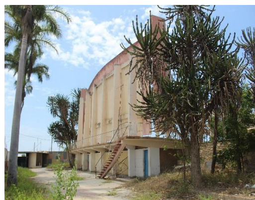
Figura 48. Cine Flamingo, acesso circulação. saída de emergência 2018
