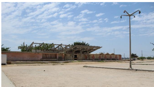
Figura 45. Cine Flamingo, exterior Vista frontal, estacionamento. 2018
