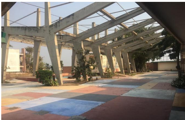
Figura 43. Cine Flamingo, interior. Recinto de entrada. 2018
