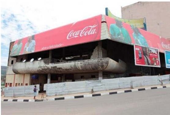
Figura 19. Província da Huíla. Lubango. Cinema Infante Sagres / Data: 1975 / Arquiteto. Luís Taquelim / Lotação: 800. Vista Exterior.
