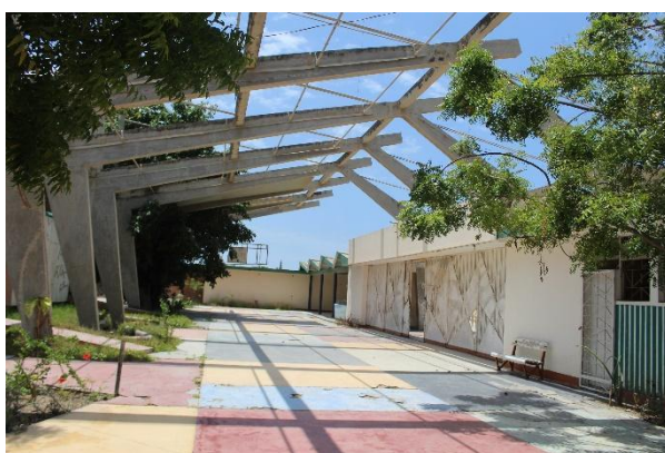
Figura 47. Cine Flamingo, interior, acesso de circulação. 2018
