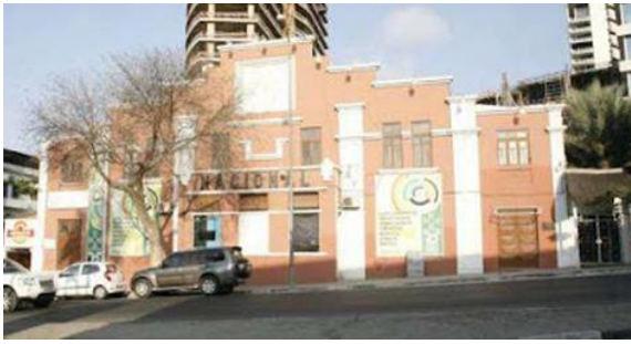
Figura 17. Cine – Teatro Nacional / Data: 1932 / Arquitetura: Vasco Vieira da Silva. Vista Exterior (2015)
