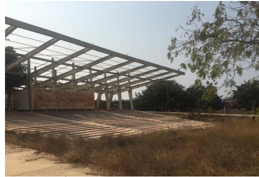
Figura 42. Cine Flamingo, interior. Área de anfiteatro 2018
