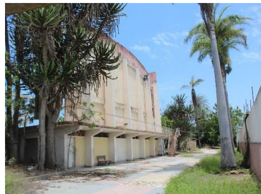
Figura 44. Cine Flamingo, interior. Acesso atrás do ecrã
