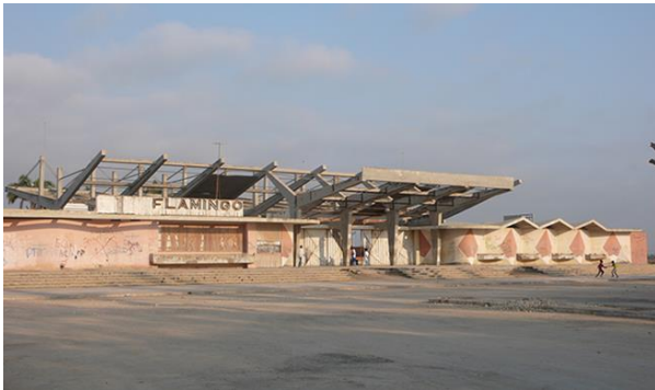
Figura 41. Cine Flamingo, exterior. Vista Frontal. 2018
