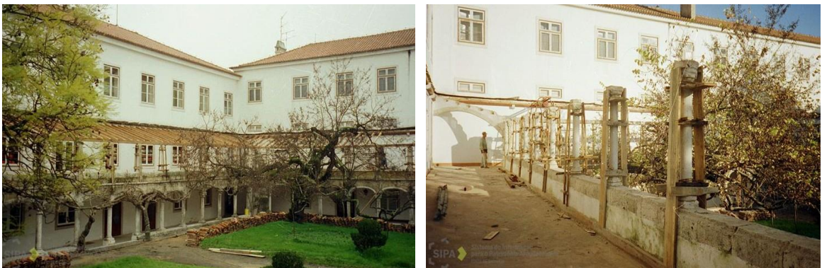
Figura 2.29 - Obras no Alpendre do Claustro da Moura em 1994 e 1995 Fonte: (DGPC, 2001)
