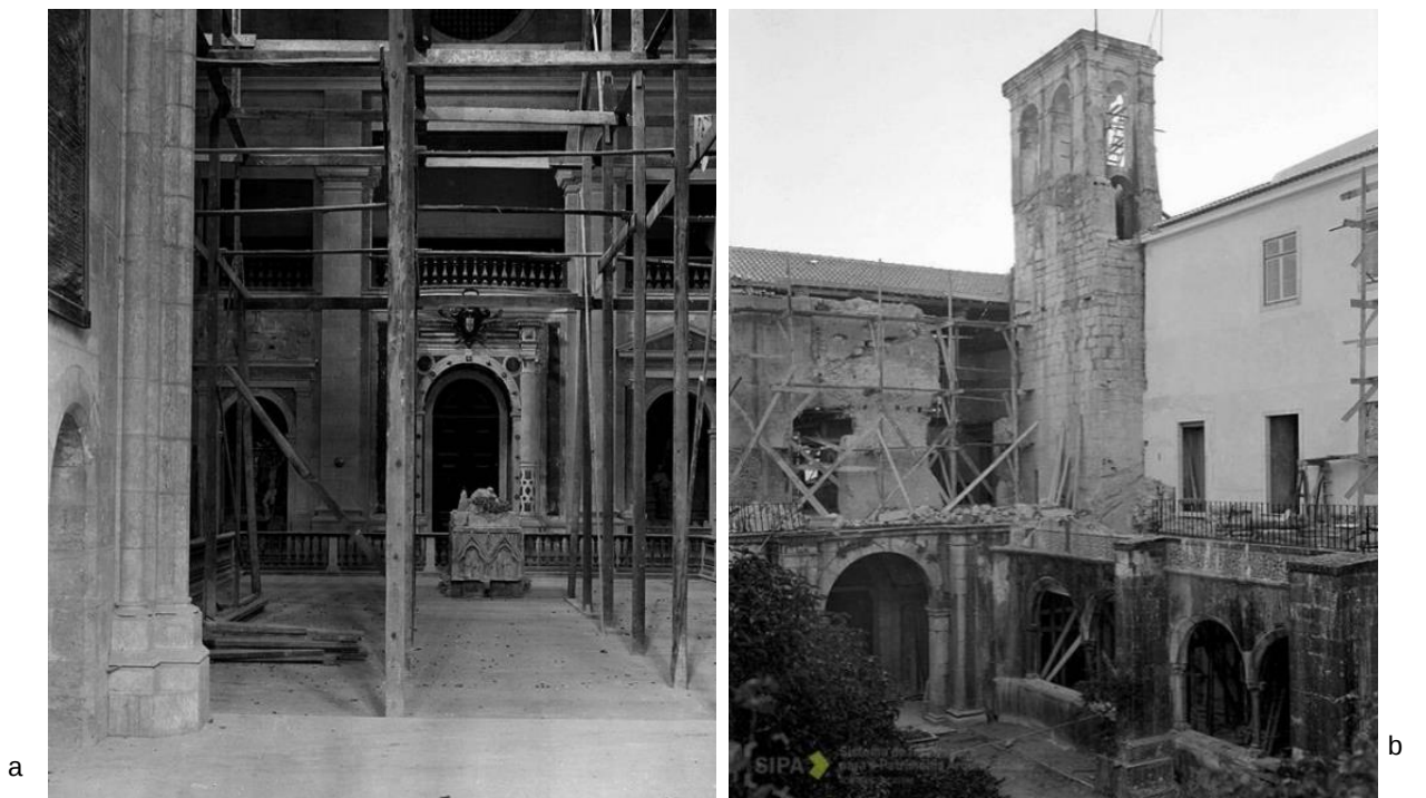
Figura 2.28 - A remodelação da igreja em a), e as obras na torre sineira e do claustro em b) Fonte: (DGPC, 2001)
