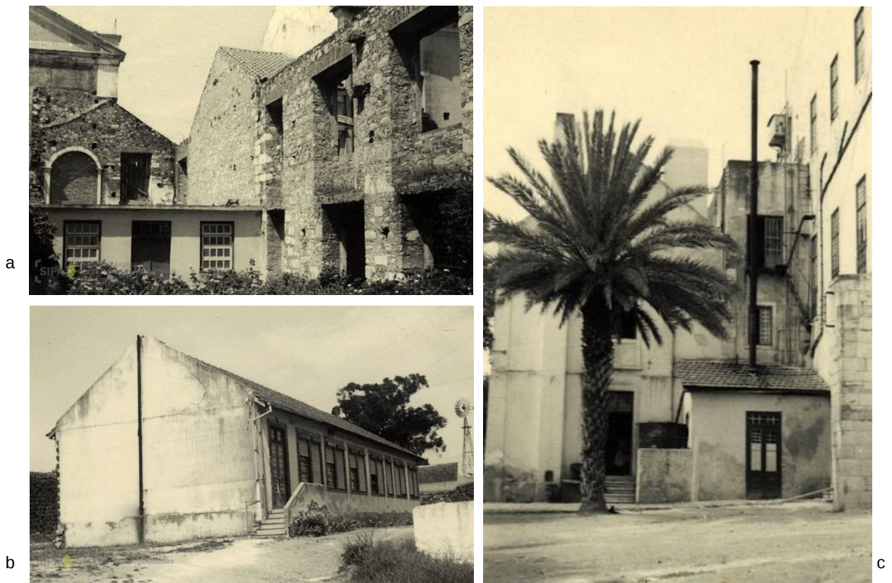
Figura 2.25 - Partes do edifício antes das obras de 1945. Ruínas em a); enfermaria em b) e a cozinha em c). Fonte: (DGPC, 2001)
