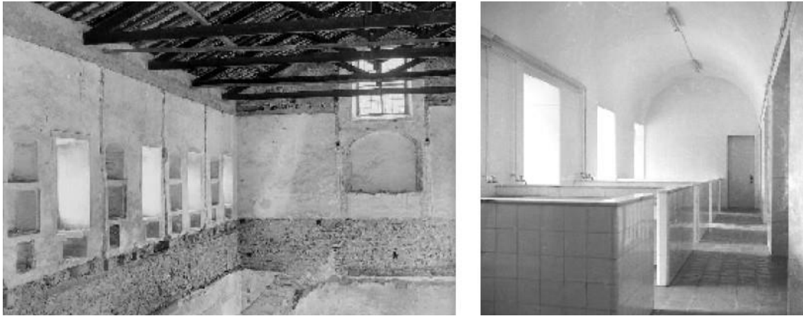
Figura 3.1 - Mosteiro S. Mamede de Lorvão durante as obras de adaptação a hospital psiquiátrico Fonte: (DGPC, 2001)
