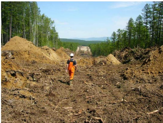
Fig. 1 – Abertura de estrada com derrube de árvores
