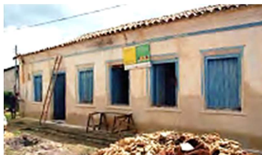
Figura 112 – Exemplo de recuperação na rua da União, nº80, Natividade, Brasil (durante a obra).
