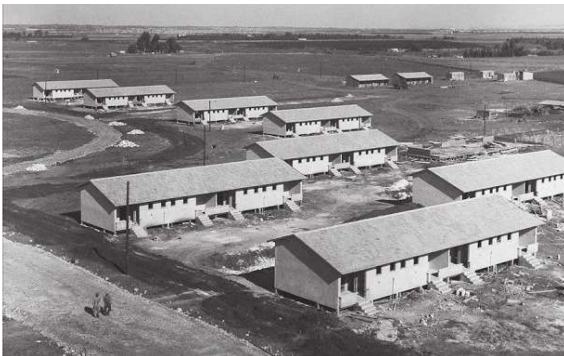
Figura 31 – Kibbutz em construção, 1940
