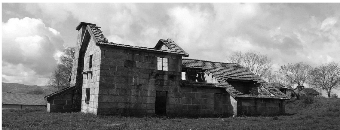
Figura 99 – Exemplo do estado de degradação de casal agrícola na Aldeia Nova do Barroso, Montalegre.
