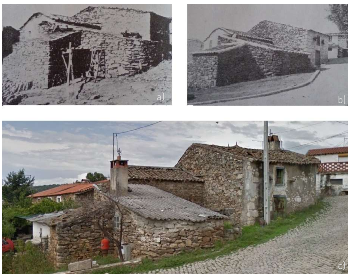
Figura 12 – Ações de intervenção no âmbito das obras de beneficiação rurais em Vale de Couce, Mirandela a) Fotografia antes da Intervenção da JCI; b) Fotografia após Intervenção da JCI; c) Imagem representativa do estado da intervenção em 2014
