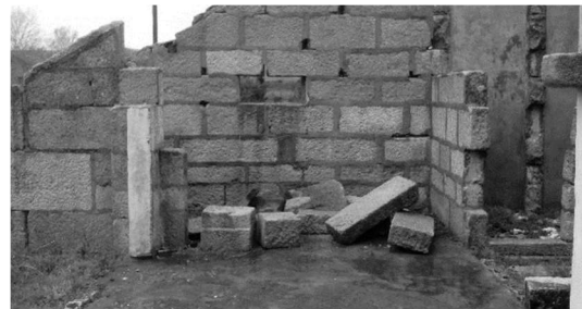
Figura 89 - Alvenaria de Granito do Casal Tipo Barroso.
