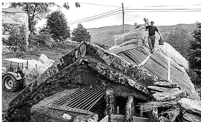
Figura 59 – Instalação de cobertura de colmo em Pitões das Júnias, Montalegre
