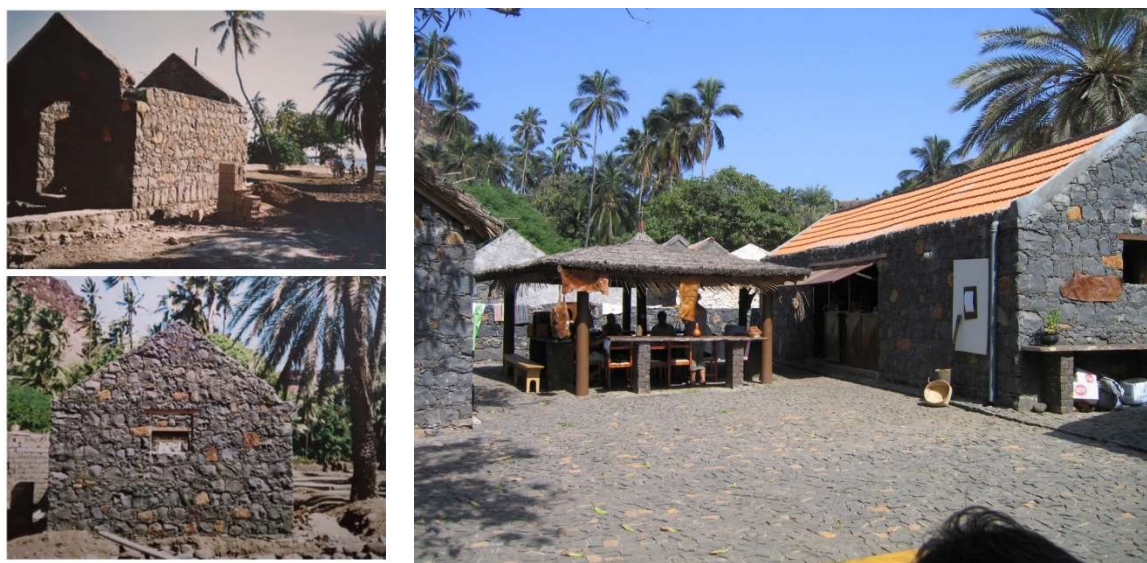
Figura 127 – Exemplo de novas construções, esplanada do Sr. Borges.
