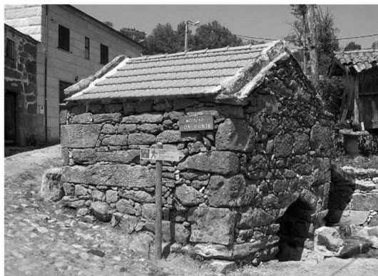
Figura 66 – Moinho recuperado em Montalegre
