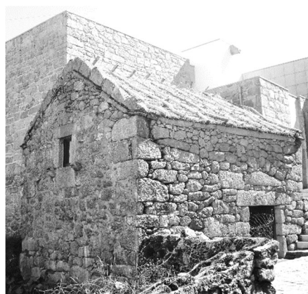
Figura 60 – Cobertura de colmo em Castro Laboreiro, Melgaço
