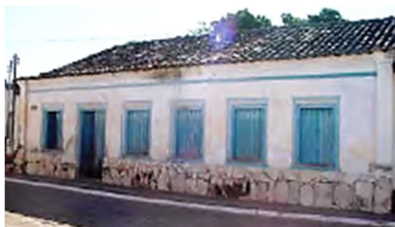
Figura 111 – Exemplo de recuperação na rua da União, nº80, Natividade, Brasil (antes da obra).
