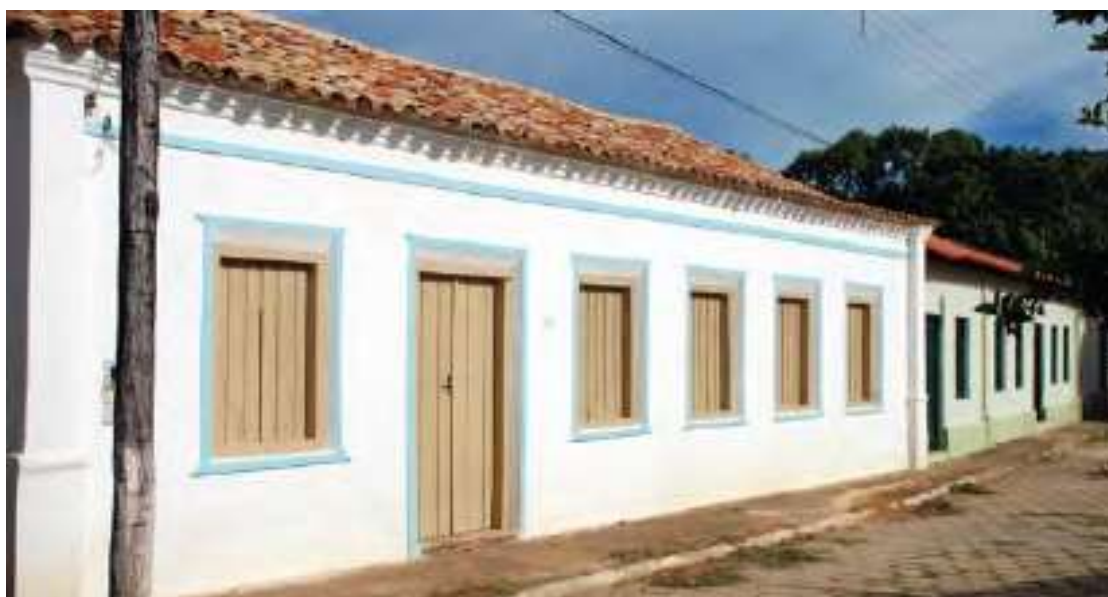
Figura 113 - Exemplo de recuperação na rua da União, nº80, Natividade, Brasil (após obra).
