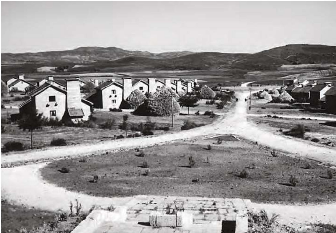
Figura 103 – Arruamento central da Aldeia Nova do Barroso (Rua de Santo Izidro), Montalegre.
