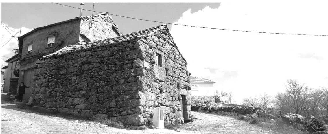
Figura 48 – Construção da Rua do Forno, Montalegre.
