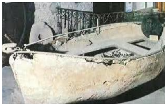
Figura 2.4 – Primeira construção de betão armado, Barco de Lambot, 1848 (Appleton, 2005)
