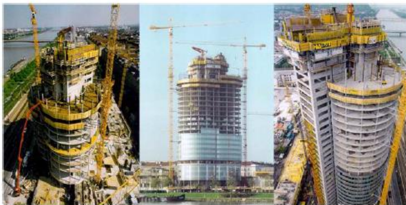
Figura 3.30 – Processo de construção do edifício Millenium Tower emViena, Austrália (Rodrgues, 2008)
