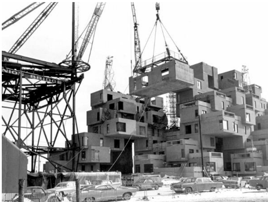
Figura 1 - Processo de Montagem do Habitat 67.
