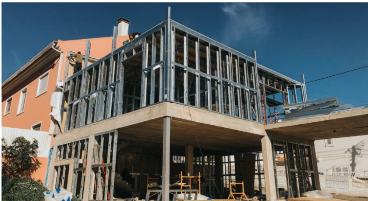
Figura 9 - Aplicação da Solução Mista (betão e LSF) na Construção da Moradia em Famaões, Odivelas.
