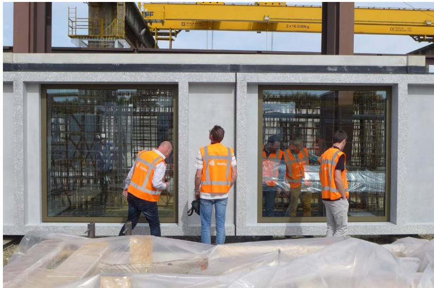
Figura 29 - Montagem do Edifício.
