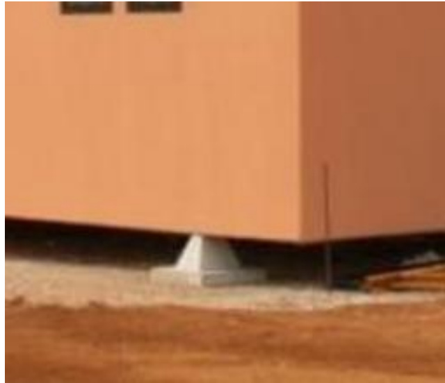
Figura 11 - Sapatas de Apoio em Betão Armado Feita Pela S.I.T.
