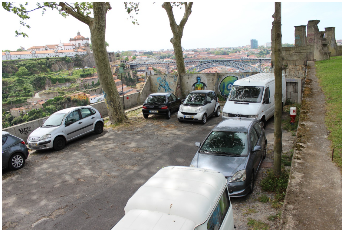
Fig. 15. Rua Passeio das Fontainhas após o desabamento.
