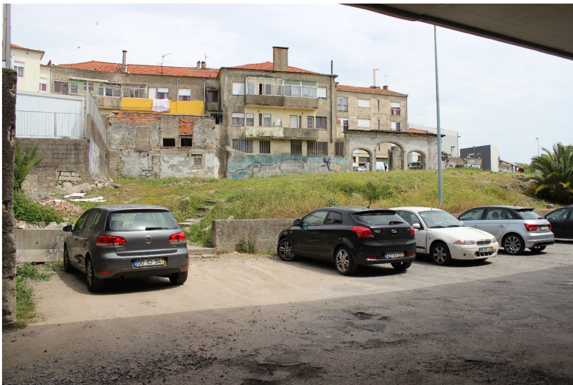
Fig. 13. Vista de espaços sobrantes a volta do Viaduto Duque de Loulé.
