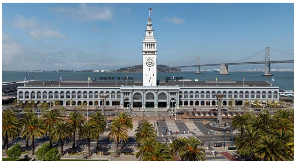
Fig. 38 Boulevard Embarcadero, construído após a demolição da via elevada
