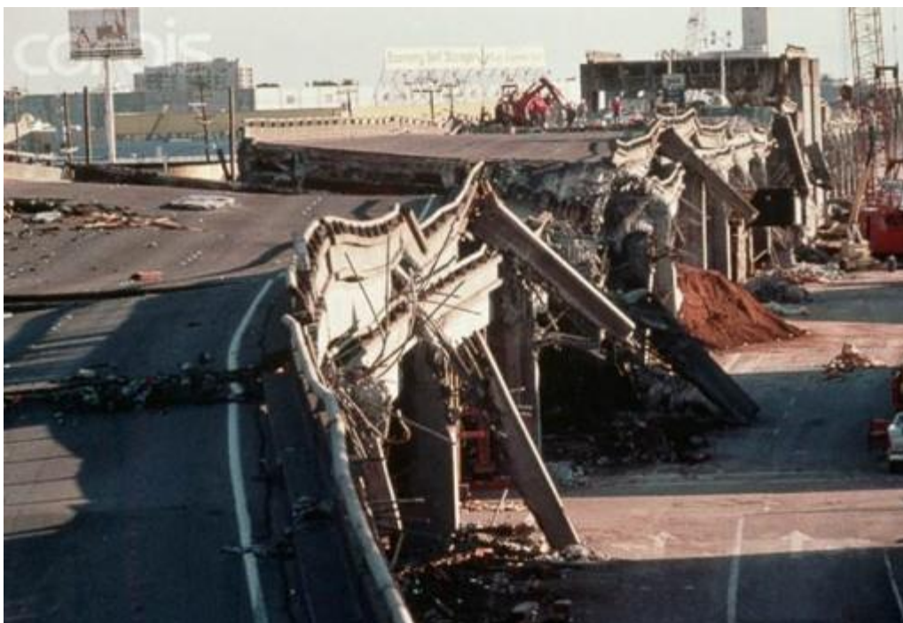
Fig. 37 Pier Freeway após o terramoto Loma Pietra.
