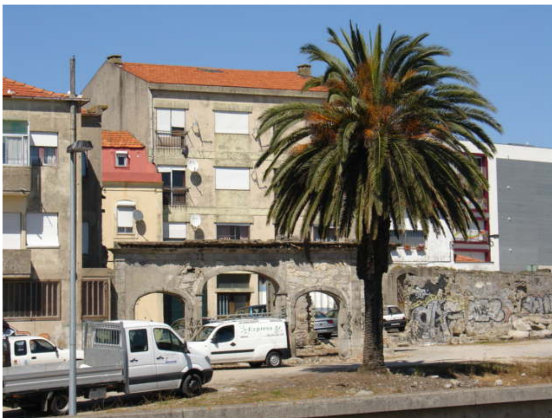
Fig. 46 Imagem de resto de fachada da Escola Comercial Oliveira Martins – Ruínas do edifício na Rua São Luís
