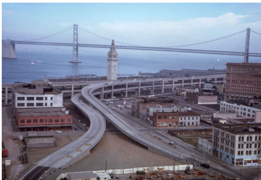
Fig. 36 Pier Freeway antes do terramoto
