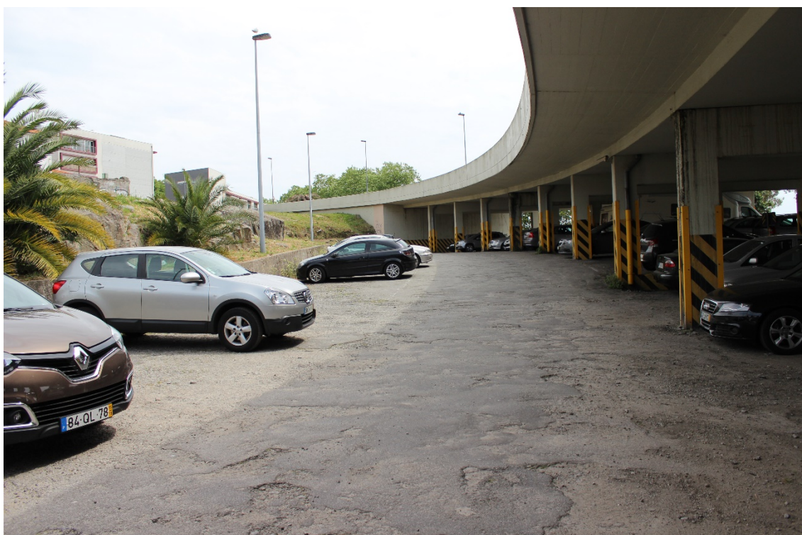
Fig. 12. Área de estacionamento sob o Viaduto Duque de Loulé.
