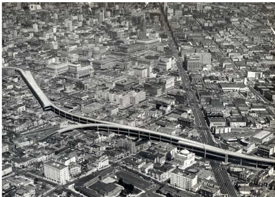
Fig. 35 Pier Freeway antes do terramoto
