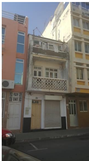
Figura 51 - Edifício sobrelevado no Plateau da cidade da Praia. (Fotografia do autor. 2015).
