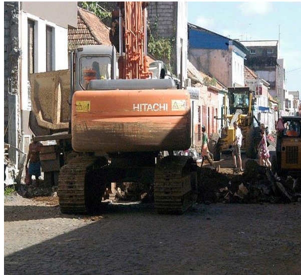
Figura 60 - Reconstrução da rua pedonal. Outubro 2010. (Fonte: et, L. P. (s.d.). Facebook. Obtida em 30 de outubro de 2016, de "II obras Rua 5 de Julho":
