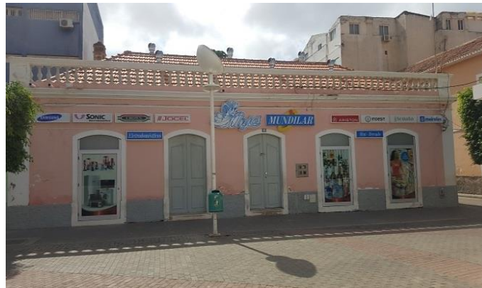
Figura 48 - Casa comercial no Plateau da cidade da Praia. (Fotografia do autor. 2016).
