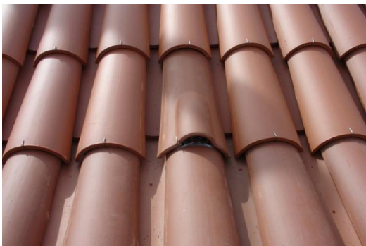
Fig. 43 – Telhas de ventilação
