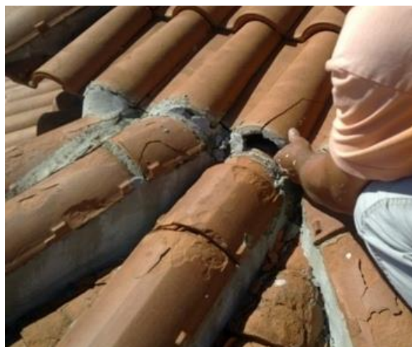
Fig. 25 – Telha Quebrada
