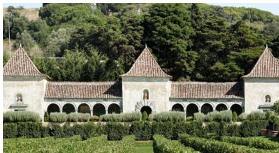
Fig. 8 – Fachada da Casa da Bacalhoa, Setúbal.
