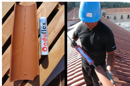
Fig. 44 – Colagem e Fixação das Passadeiras com Silicone
