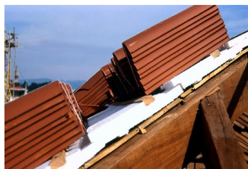
Fig. 38 - Colocação de Isolamento Térmico nas águas
