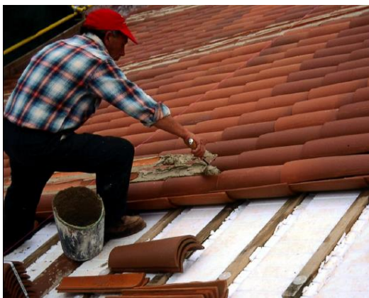
Fig. 39 – Fixação com Argamassa pobre nas Passadeiras
