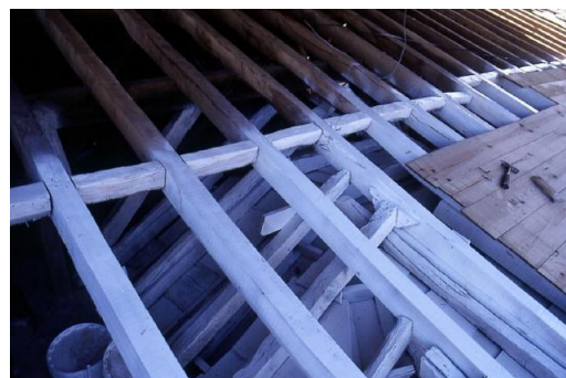
Fig. 36 – Introdução da Tinta Intumescente na madeira
