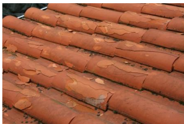
Fig. 27 – Descasque da Telha
