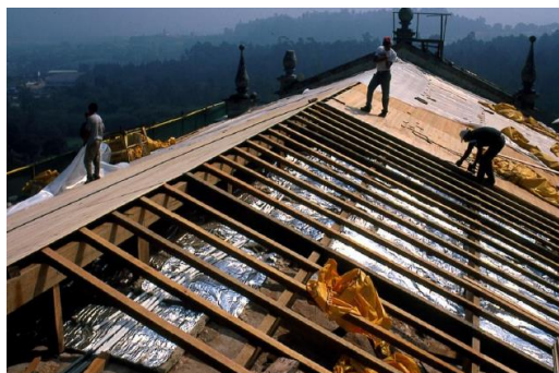
Fig. 37 – Colocação de Isolamento Térmico no Vão
