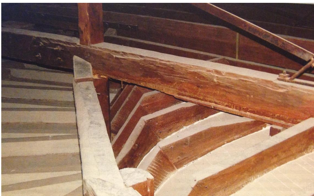
Fig. 29 – Tintas Intumescentes colocada na estrutura de madeira
