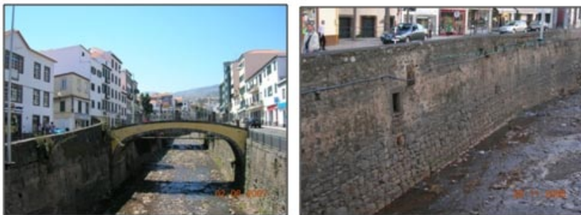
12. Muralhas de protecção da Ribeira de Santa Luzia – permanências do século XIX.
