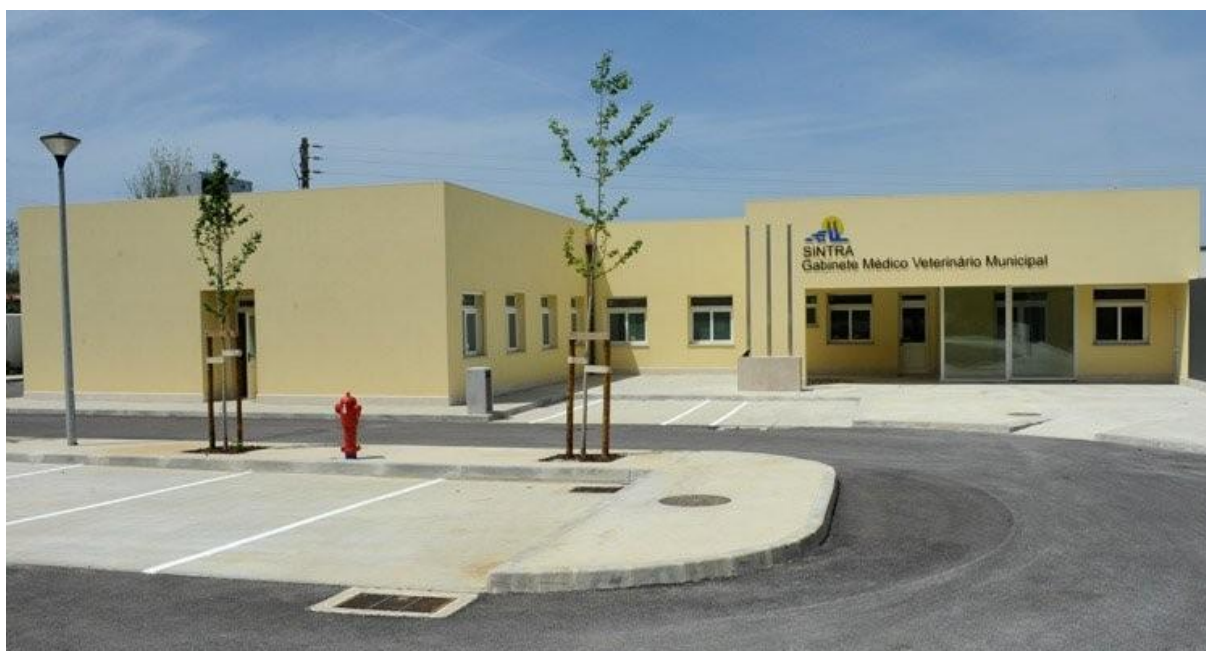
Figura 1 – Edifício do Gabinete Médico Veterinário de Sintra. Câmara Municipal de Sintra, 2017.
