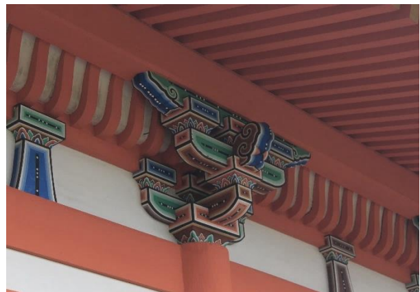
Figura 58 Detalhes da pilastra do Amida-Do (Amida Hall), Kiyozumi-Dera, Kyoto, da autora.
