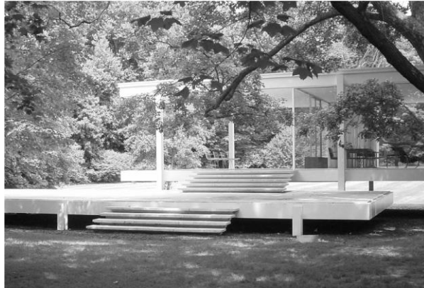
Figura 101 Vista exterior da Farnsworth House; o seu interior transparente traz a paisagem para dentro da casa.
