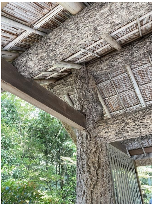
O Sotokoshikake possui um grande telhado suportado por pilares de troncos com a casca ainda presa.
