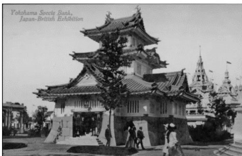
Figura 28 Edifício do Yokohoma Specie Bank, Expo 1910, Londres, em The Japan-British Exhibition , plate 24.
