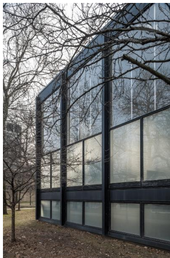
Figura 75 IIT, composição de fachada do S.R. Crown Hall de painéis de vidro e aço negro, em WikiArquitectura.
