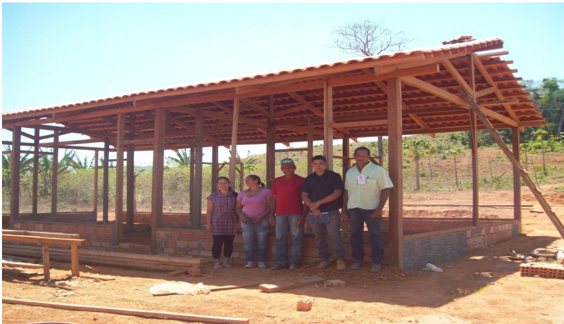
Foto 5: Granja da CFR de São Félix do Xingu-PA (em construção).
