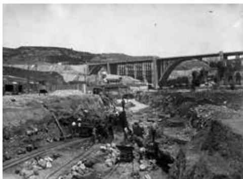
d) Obras de cobertura da ribeira de Alcântara. Fonte: "Exposição água vai", C.M.L. (2019).
