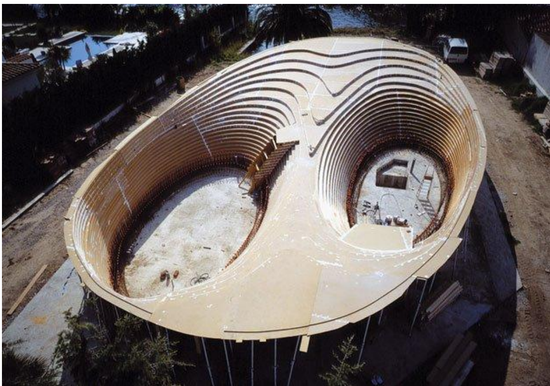
Imagem 6 - Vila Nurbs, 2009, em Barcelona, por Enric Ruiz Geli e Lopetegi Ekhi, precesso de construção da trama metálica.
