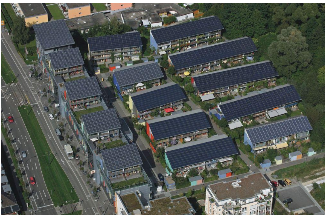
Imagem 4 - The Solar ship, 2000, em Freiburg, Alemanha, por Rolf Disch, perspectiva aérea.
