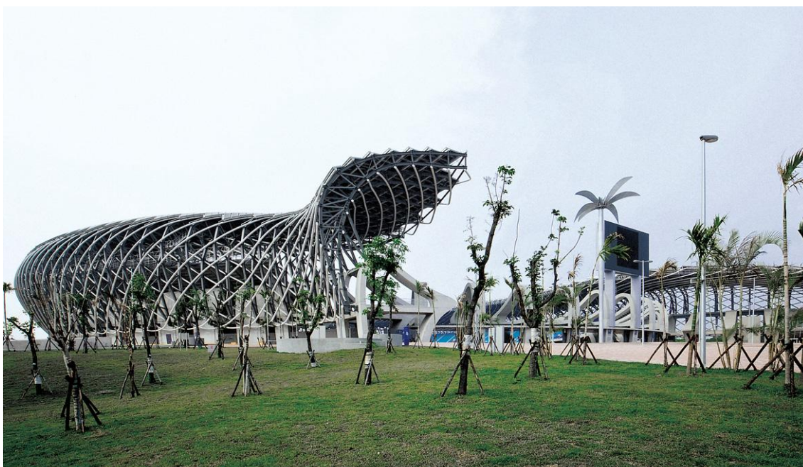
Imagem 42 - Estádio de energia solar, Jogos Mundiais 2009, em Kaohsiung, Taiwan, por Toyo Ito, vista
