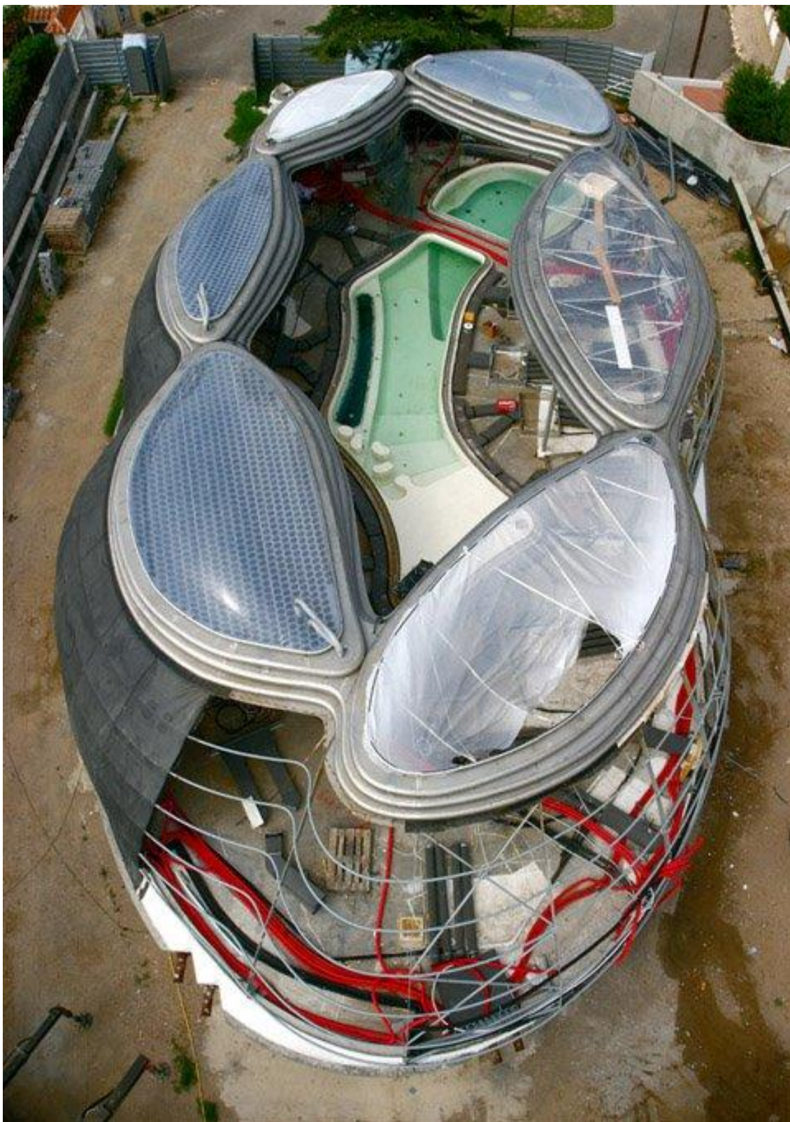
Imagem 25 - Vila Nurbs, 2009, em Barcelona, por Enric Ruiz Geli e Lopetegi Ekhi, aplicação das “veias” – canalização de infra-estrutura e primeiros fechamentos.
