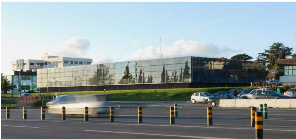
Imagem I - Operação de Coordenação de Centro Brisa, 2002, em Carcavelos, Portugal, por João Luís Carrilho da Graça e Flavio Barbini, Maria João Silva Barbini, vista do alçado sul.
