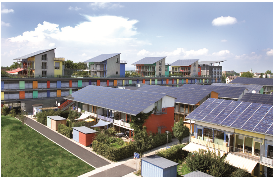
Imagem 3 - The Solar ship, 2000, em Freiburg, Alemanha, por Rolf Disch, vista.
