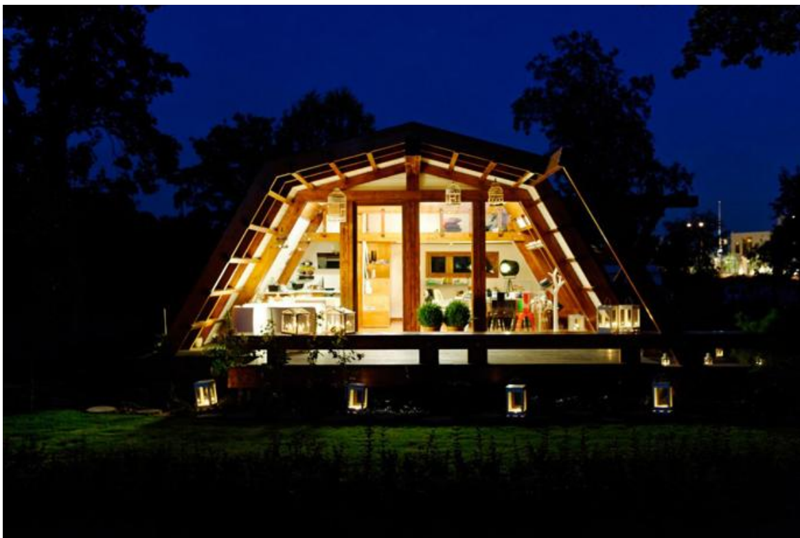
Imagem 3 - Soleta zeroEnergy, 2013 , em Bucareste, Roménia, pela Justin Capra Foundation for Investment and Sustainable Technologies (FITS), vista noturna.
