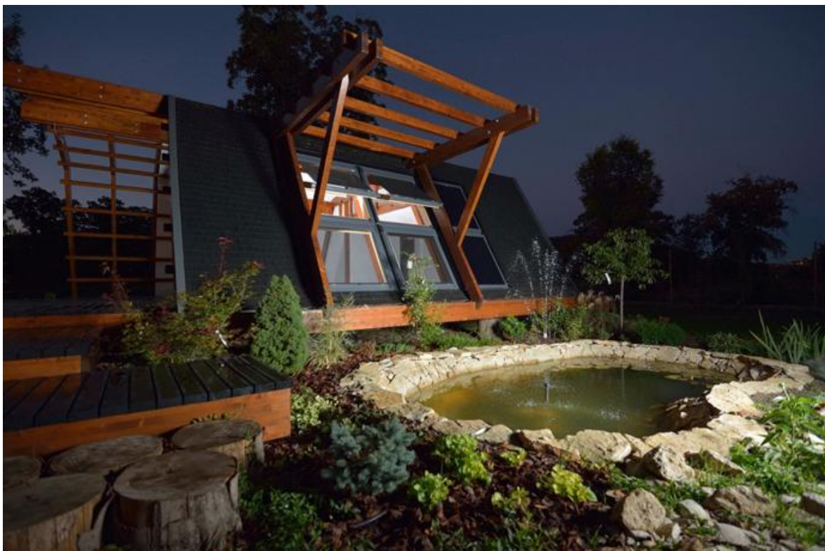
Imagens 21 - Soleta zeroEnergy, 2013 , em Bucareste, Roménia, pela Justin Capra Foundation for Investment and Sustainable Technologies (FITS), vista.
