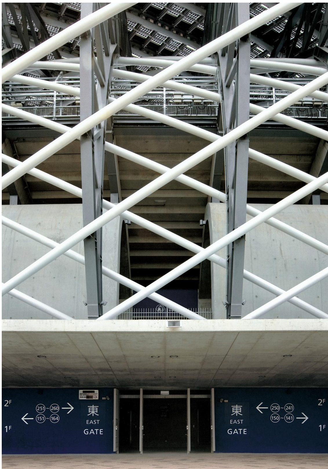
Imagem 19 - Estádio de energia solar, Jogos Mundiais 2009, em Kaohsiung, Taiwan, por Toyo Ito, estrutura
