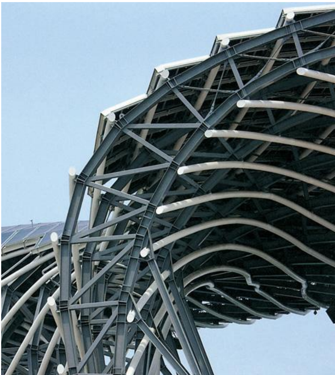
Imagem 38- Estádio de energia solar, Jogos Mundiais 2009, em Kaohsiung, Taiwan, por Toyo Ito, estrutura
