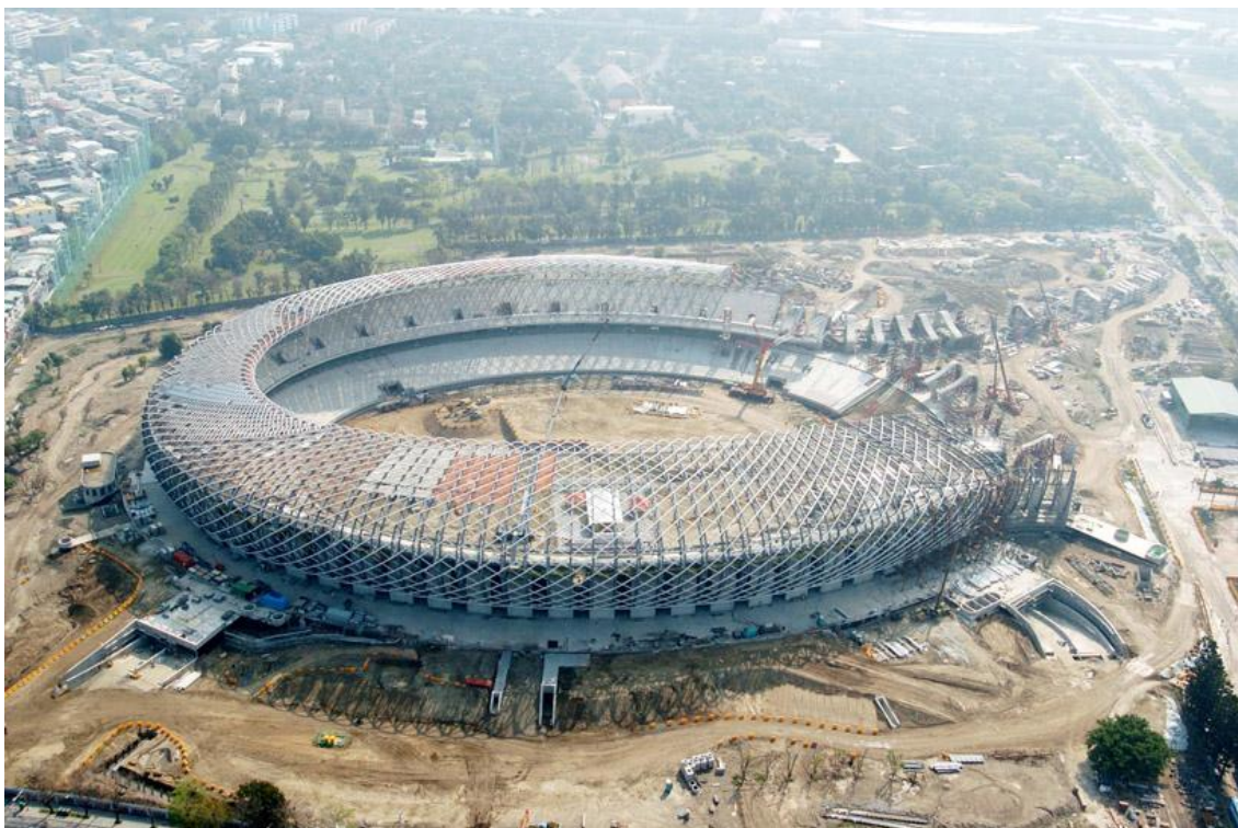
Imagem 8 - Estádio de energia sola, Jogos Mundiais 2009, em Kaohsiung, Taiwan, por Toyo Ito, construção.
