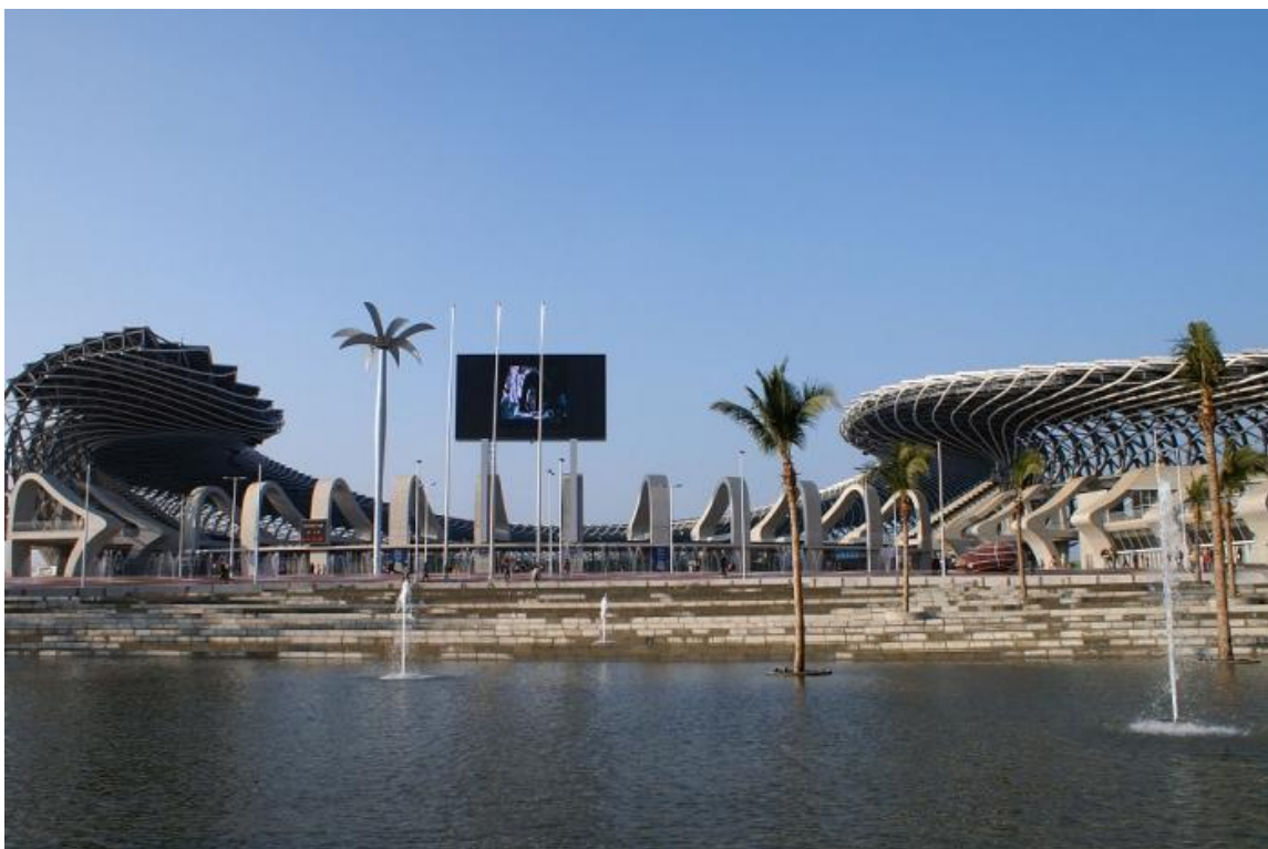
Imagem 32 - Estádio de energia solar, Jogos Mundiais 2009, em Kaohsiung, Taiwan, por Toyo Ito, vista
