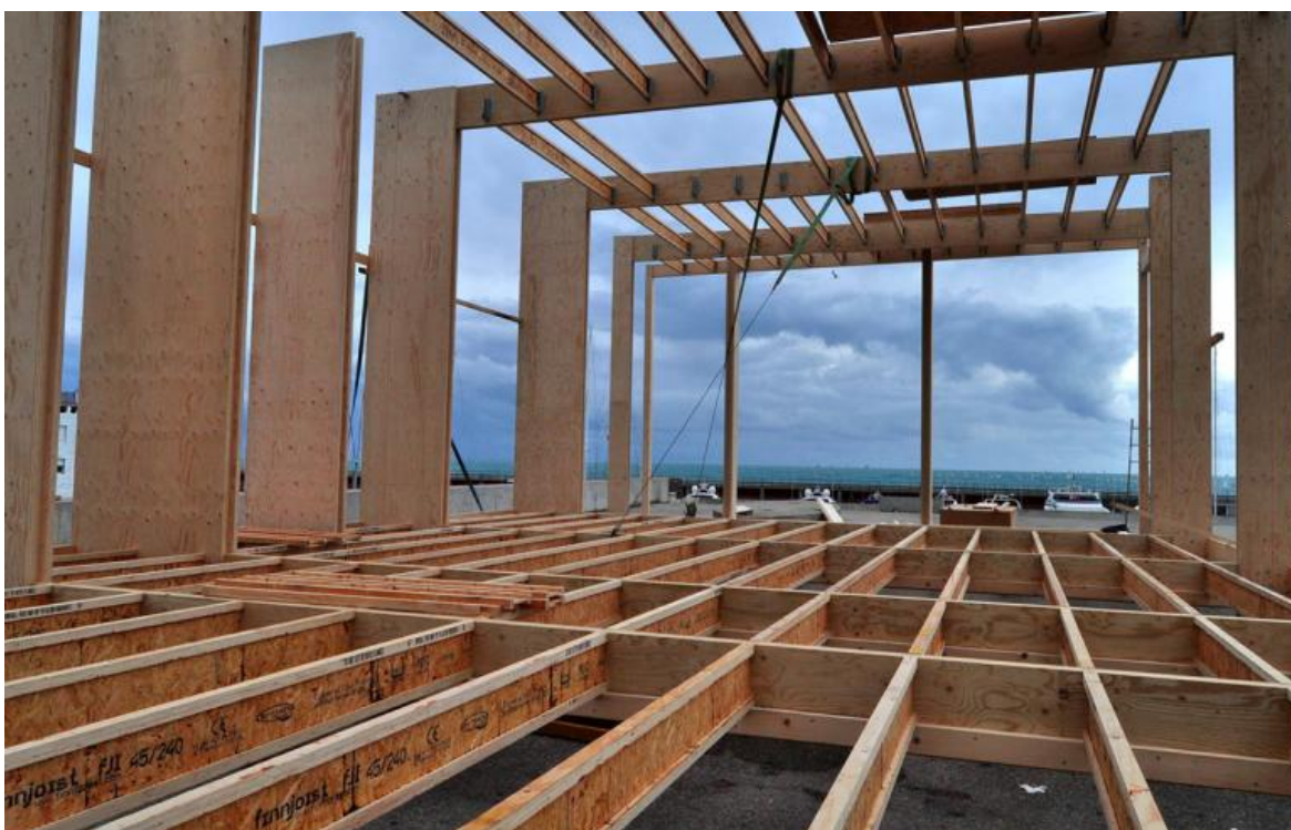
Imagem 14 - Pavilhão Endesa, 2011, em Barcelona, Espanha, por IAAC, estrutura.
