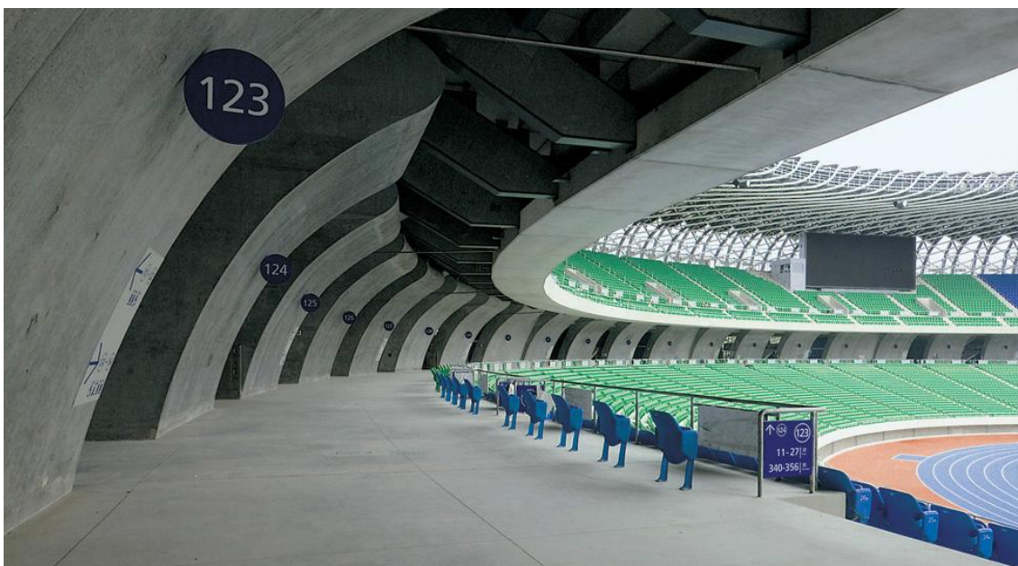
Imagem25 - Estádio de energia solar, Jogos Mundiais 2009, em Kaohsiung, Taiwan, por Toyo Ito, estrutura de betão
