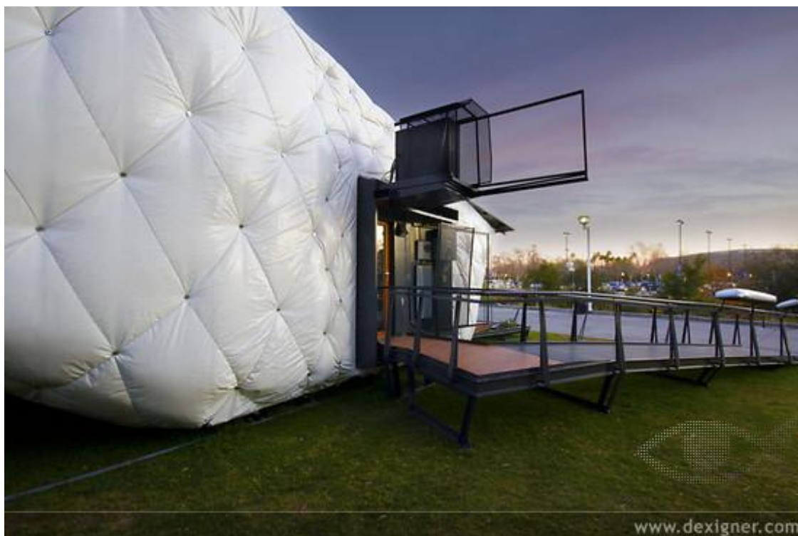
Imagem 5 - Casa CHIP (Compact Hyper-Insulated Prototype), 2011, Califórnia, Institute of Architecture (SCI-Arc) e do Instituto de Tecnologia da Califórnia (Caltech), vista.
