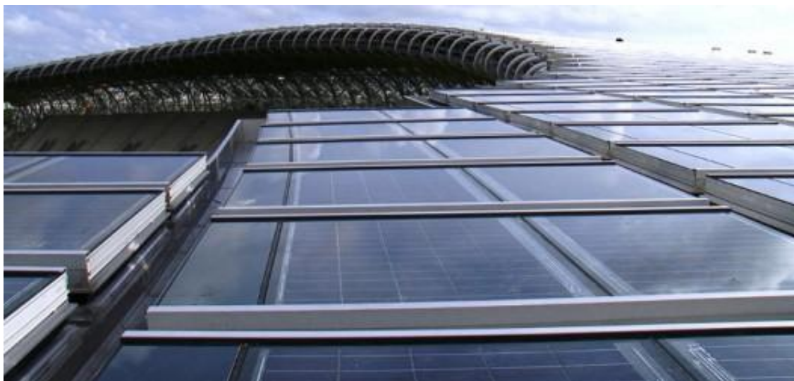
Imagem 33 - Estádio de energia solar, Jogos Mundiais 2009, em Kaohsiung, Taiwan, por Toyo Ito, painéis solares
