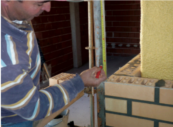
2. Marcação de fiadas de tijolo
