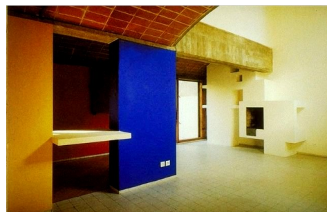
22. Imagem de cruzamento do betão e o revestimento de tijolo na abóbada interior
