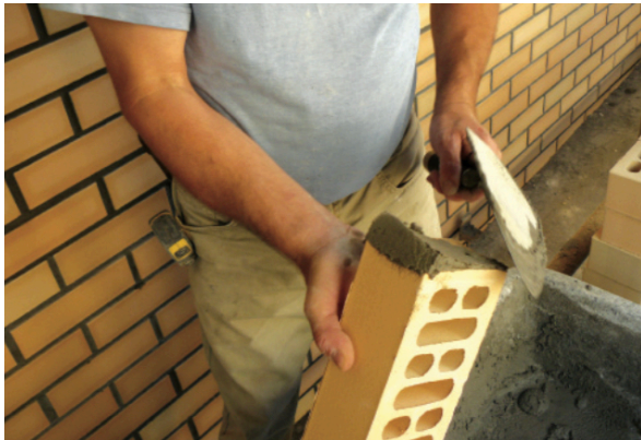
6. Preparação prévia do fecho de junta vertical
