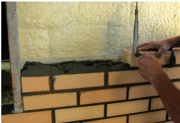
7. Arrastamento do tijolo face à vista
