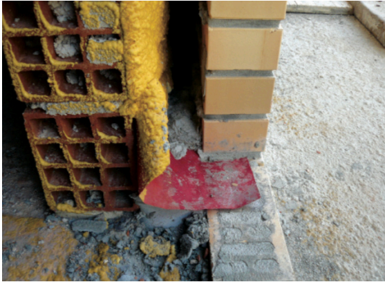
4. Assentamento do pano exterior sobre a tela de apoio elástica
