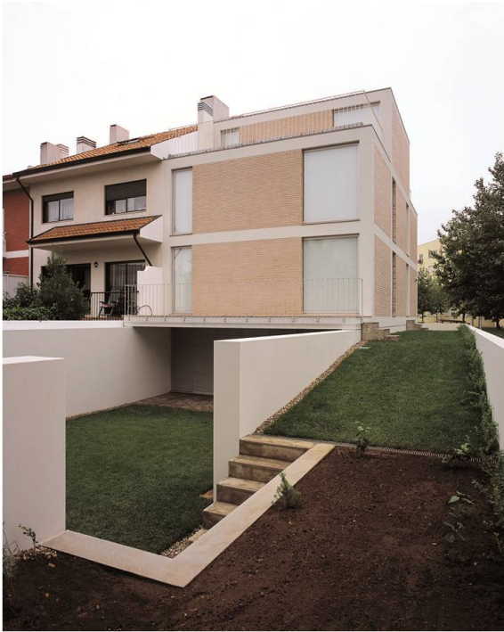
31. Imagem da fachada Norte onde se observa o piso recuado
