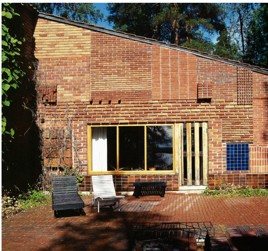
39. Diferentes técnicas, tijolos e assentamentos do material no interior do patio
