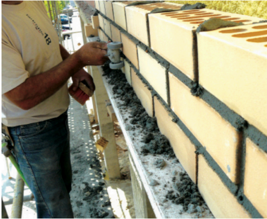
9. Carrinho para refinamento das juntas
