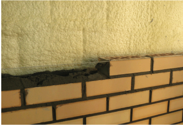
5. Argamassa para a execução da junta horizontal
