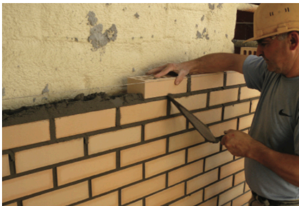
8. Remoção da argamassa das juntas após o assentamento
