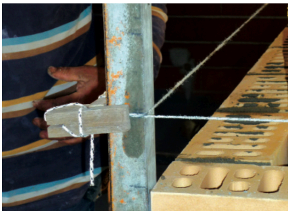
3. Definição dos alinhamentos do assentamento
