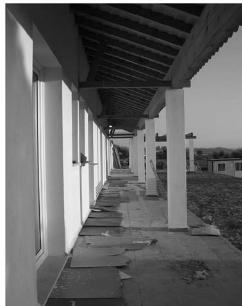
Figuras 13 a, b - Alçado Sudoeste (fotografia tirada no Inverno)– Devido à inclinação do sol e à orientação da fachada, os vãos envidraçados recebem ganhos directos na estação fria
