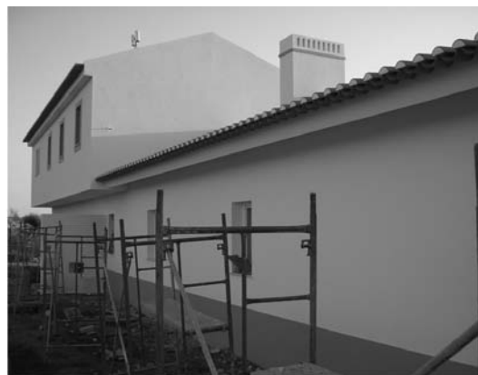
Figura 10 - Vista da Fachada Nordeste
