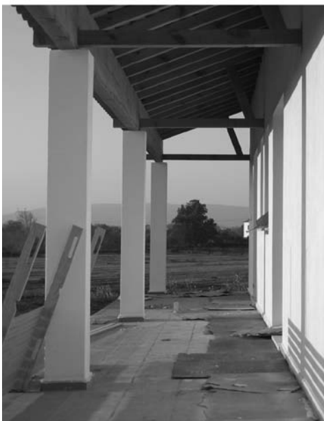
Figuras 13 a, b - Alçado Sudoeste (fotografia tirada no Inverno)– Devido à inclinação do sol e à orientação da fachada, os vãos envidraçados recebem ganhos directos na estação fria
