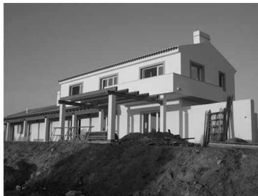
Figura 9 - Vista da Fachada Sudoeste
