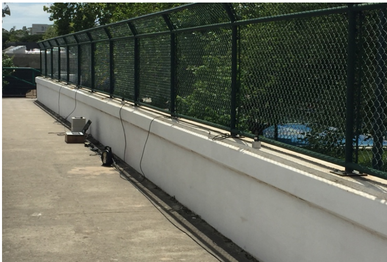
Figura 3:10: Posicionamento dos acelerômetros nas vigas longitudinais e do sistema de aquisição no tabuleiro.
