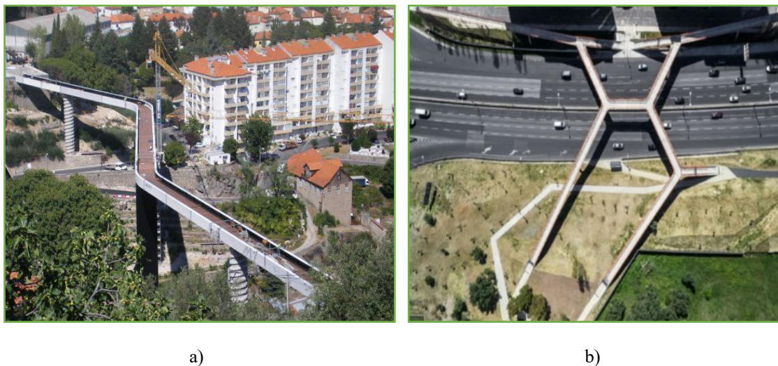
Figura 1:1: Exemplos de estruturas pedonais: a) ponte pedonal sobre ribeira da carpinteira; b) ponte pedonal sobre a segunda circular em Lisboa (Portugal, s.d.).
