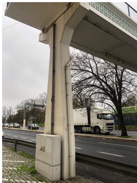
Figura 3:6: Fotografia dos pilares construídos (dezembro, 2019)
