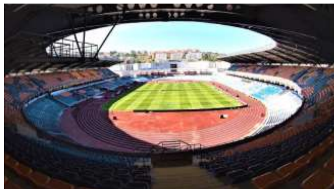
Figura 2. Novo Estádio Cidade de Coimbra
