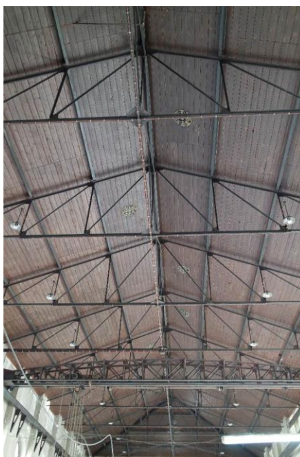
Fig. 26 - Cobertura da Central Foto da Autora
