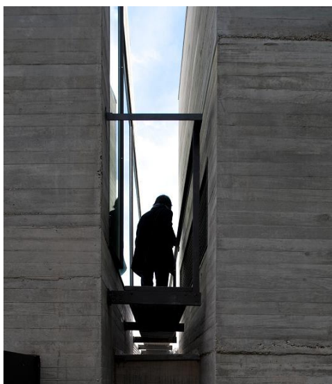
Fig. 33 - Ligação entre a Casa das Caldeiras e o Centro de estudo Fonte: Foto de Fernando Guerra
