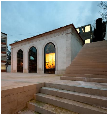
Fig. 29 - Casa das Caldeiras - Alçado lateral Fonte: Foto de Fernando Guerra
