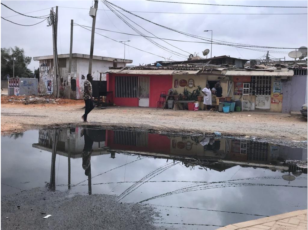
Fig.6. Falta de saneamento básico e cabos elétricos expostos no bairro da Terra-Nova (imagens de autor, 2018)
