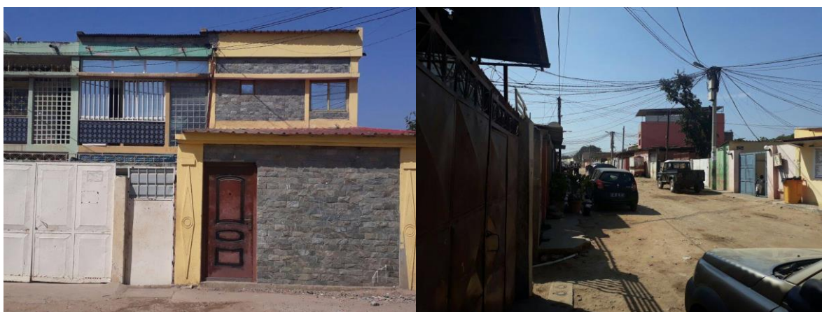
Fig.12. Fachada reabilitada por morador e sistema elétrico exposto (imagem de autor, 2018)
