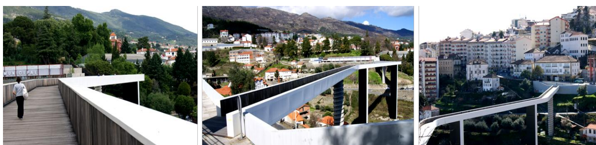
Fig. 40 Ponte Pedonal da ribeira da Carpinteira, Carrilho da Graça, 2009.
