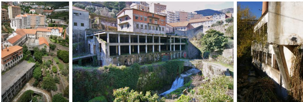
Fig. 46 Edificações fabris sobre a linha de água, Fábrica António Estrela e Fábrica José da Cruz Fael Júnior / Santos Pinto, ribeira da Carpinteira, 2013.
