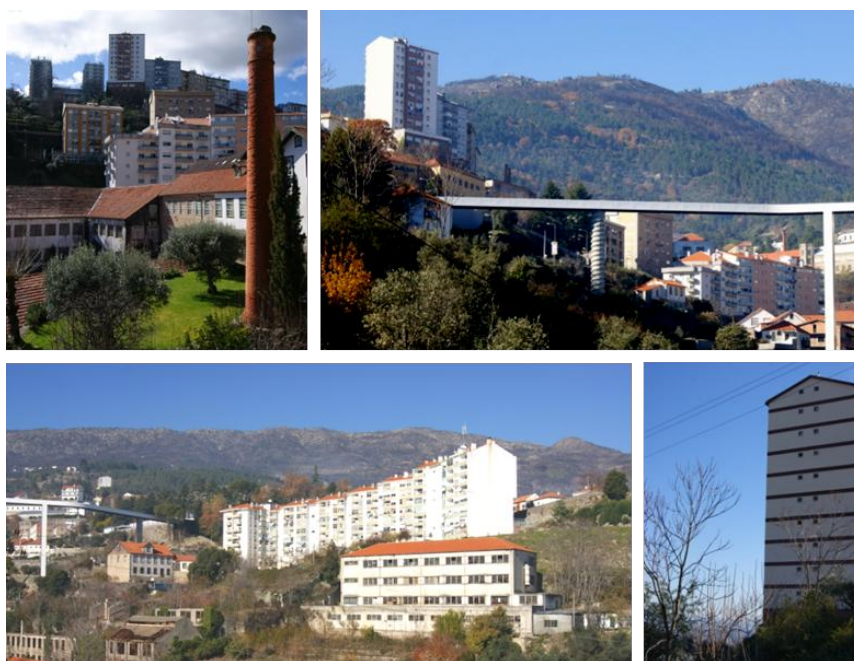
Fig. 49 Edifícios habitacionais de cérceas exageradas, limite do vale da ribeira da Carpinteira, 2014.
