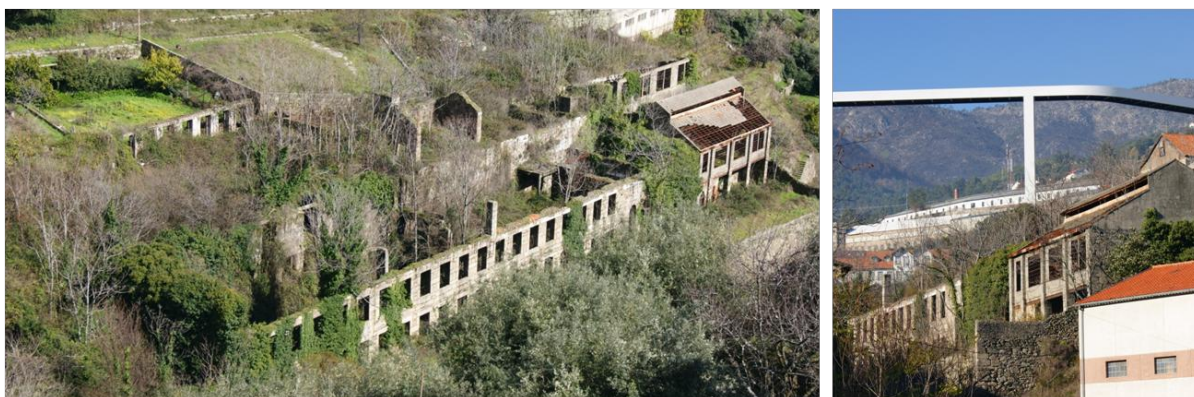
Fig. 34 Ruínas de edifícios fabris, zona das Polras, margem esquerda da ribeira da Carpinteira, 2013.
