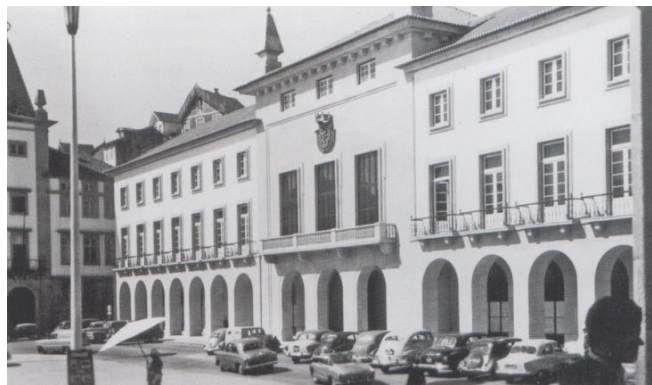
Fig. 3 Edifício da Câmara Municipal de 1958, Covilhã, 1960-1970.
