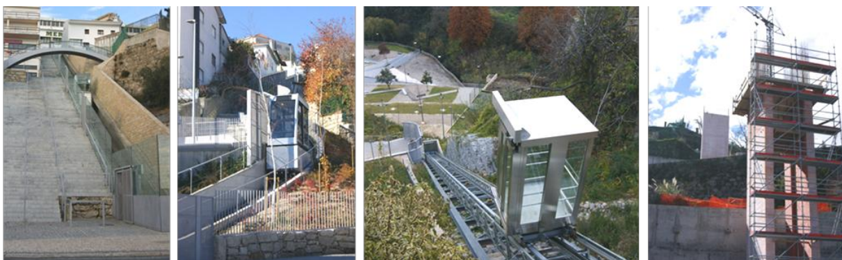
Fig. 39 Elevador de S. André; Funicular de S. João de Malta; Elevador da Goldra e Elevador do Jardim Público (em construção), 2014.
