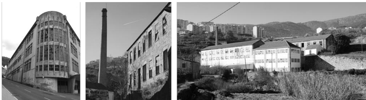
Fig. 48 Fábrica Nova Penteação e Fiação de Lãs e Fábrica José da Cruz Fael Júnior / Santos Pinto, zona da várzea, 2014.
