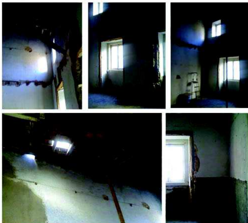
02.05 Fotografias da Associação Renovar a Mouraria da 7ª semana de obras
