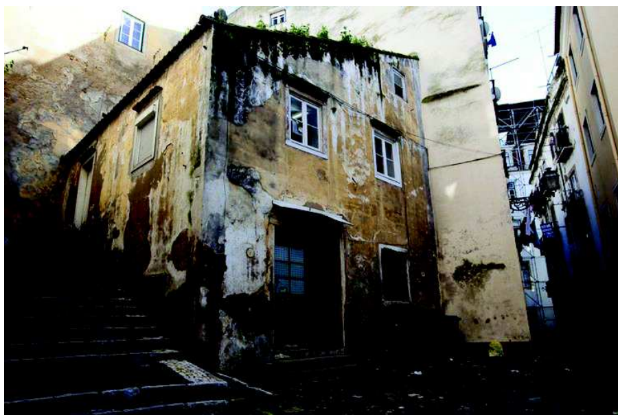
02.03 Edifício devoluto cedido pela Câmara Municipal de Lisboa à ARM para futura Casa Comunitária da Mouraria.
