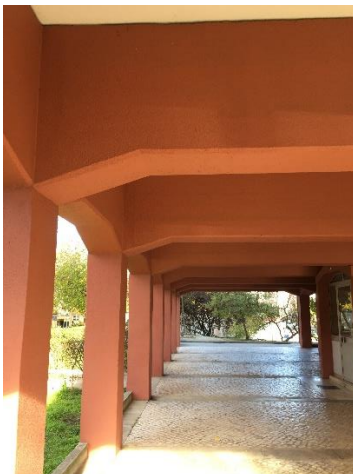
Figura 1.4 – Embasamento de betão armado: a) Vista dos pórticos de embasamento; b) Pormenor do projeto de estruturas do caso de estudo referente aos pórticos que constituem o embasamento (ICESA, 1974).
