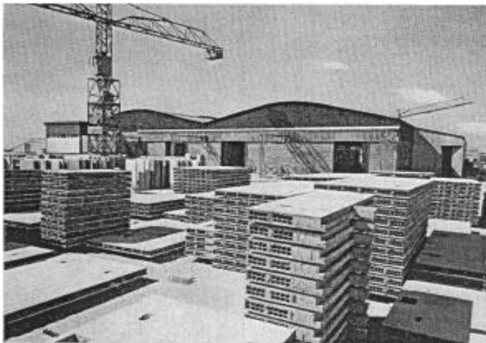
Figura 3.13 - Parque de armazenamento de materiais e elementos pré-fabricados (Pinto, 1969).
