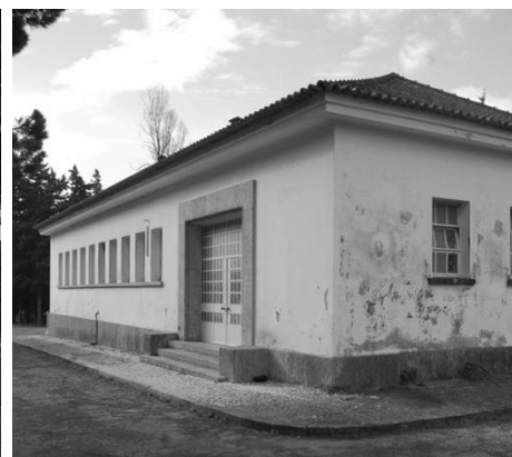
Fig. 28 – Edifício da Cozinha (2013)
