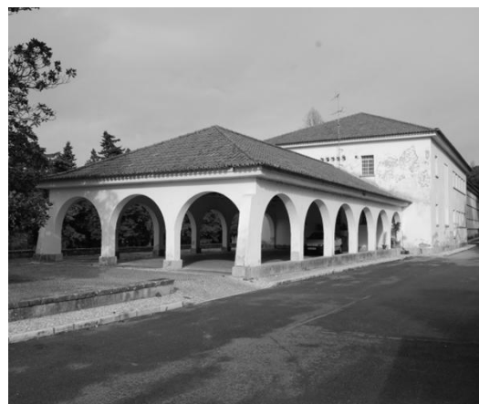
Fig. 32 – Edifício Horizonte (Fachadas Sul)
