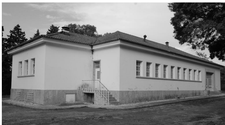
Fig. 27 – Edifício da Cozinha (2013)
