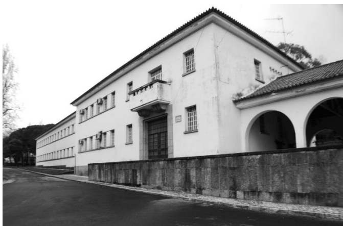
Fig. 31 – Edifício Horizonte (Fachada Poente)
