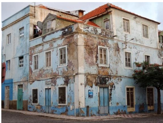
Figura 11: casa colonial Mindelo - São Vicente (Fonte http://www.asemana.publ.cv/spip.php?article75427 em 25/03/2015)
