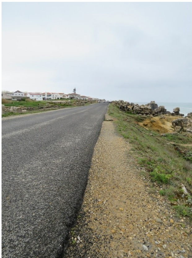
Figura 32 – Fotografia da estrada principal que faz a demarcação entre os elementos compostos de arriba / oceano e envolvente vegetal e arenosa. Miguel Patrício, 2018.
