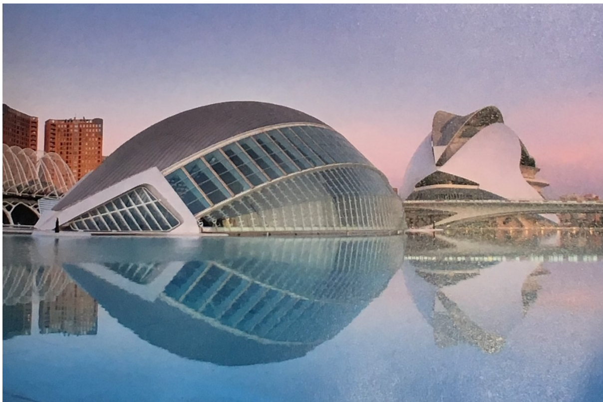
Figura 18- Santiago Calatrava. L'Hemisfèric - Imax Cinema, Planetário e Laserium. City of Arts. Valência - Espanha. 1996. Fonte:
