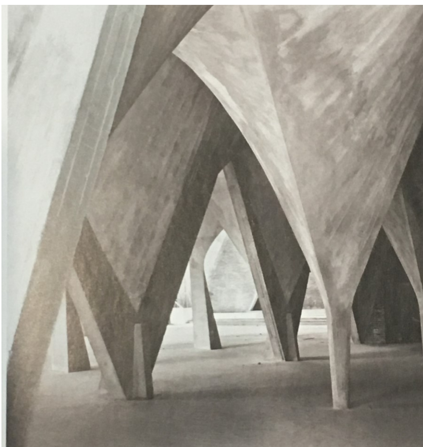
Figura 12 – Félix Candela. Imagem durante a construção. Igreja de Nossa Senhora Milagrosa, Navarte - Cidade do México.1953. (Alanís, 2010, p. 31)
