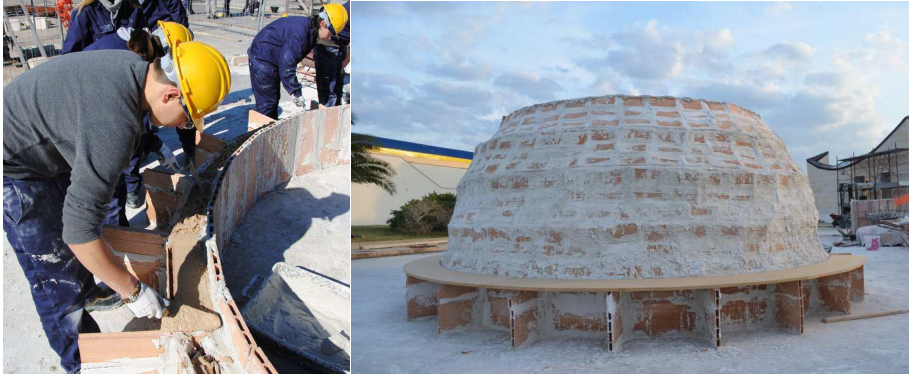
FIG.7. and 8. Stage Santi Quattro Coronati: Masonry Dome
