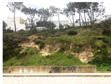
1. Encosta degradada e construções em risco
