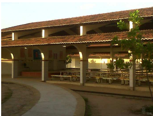
FIGURA 10 – Refeitório com acessibilidade da Escola Municipal PLFM Fonte: Acervo da pesquisa
