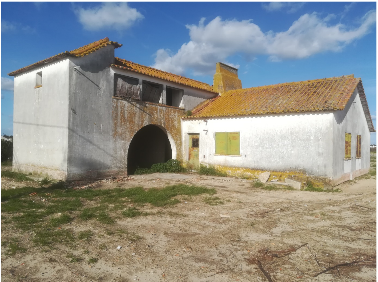
Figura 12: "Urze" – Casal n.º 197. Fonte: Fotografia do autor, 2018.
