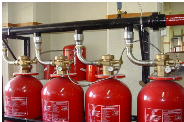
Fig. 5 – Sistema Automático de Detecção de Incêndios (SADI)
