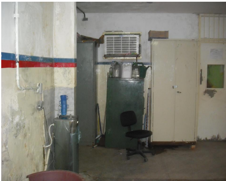
Foto 3 – Esquina do corredor central da escola (precariedade de móveis e utensílios)
