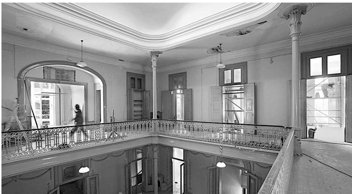
Imagem 46: Vista do piso superior antes da reabilitação, (in Gepctrofa 2024).
