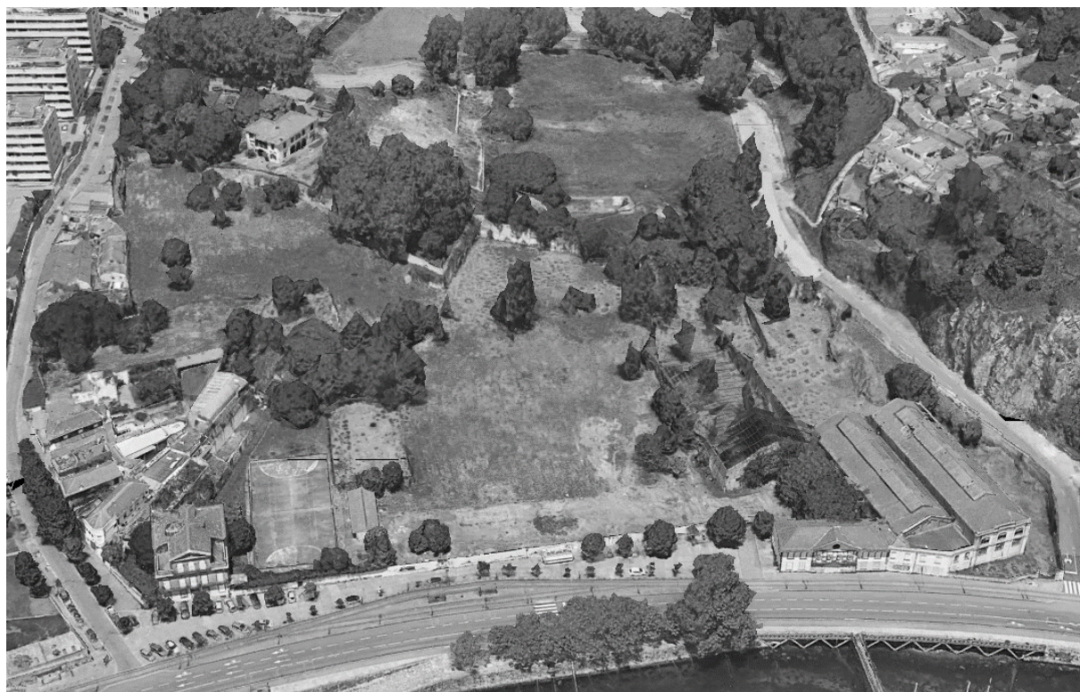
Imagem 1: Vista aérea do terreno na Rua do Ouro, (in Google 2024).
