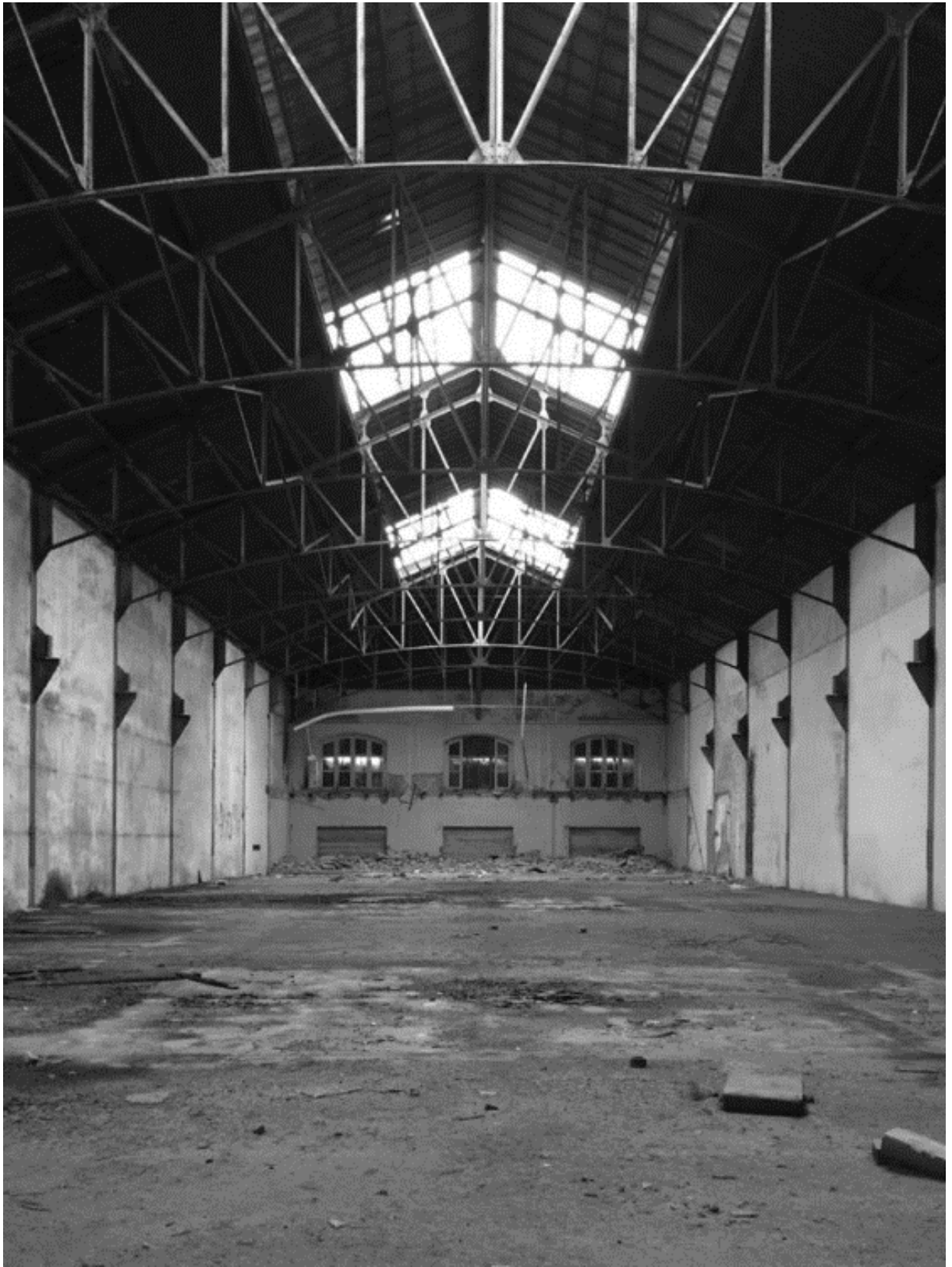
Imagem 6: Vista Sul do interior da galeria da Fábrica do Gás, (in Fernando Miranda 2016).
