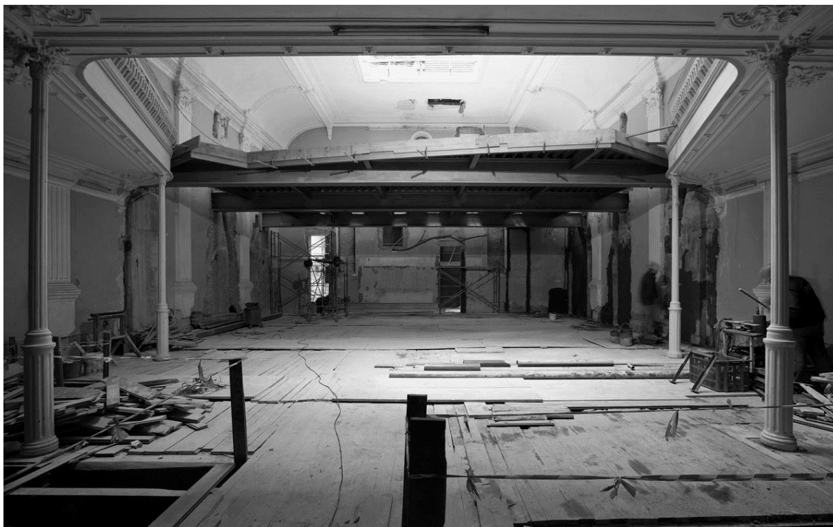
Imagem 33: Vista interior em processo de reabilitação, (in Archdaily 2024).
