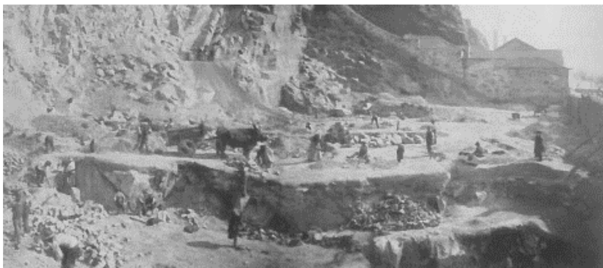
Imagem 23: Terraplanagem para a construção dos pavilhões de 1907, (in Fernando Miranda 2016).
