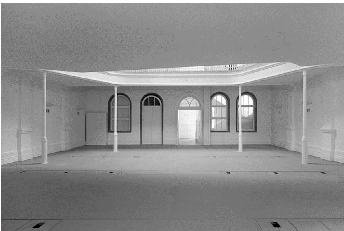
Imagem 34: Vista interior após a reabilitação, (in Archdaily 2024).
