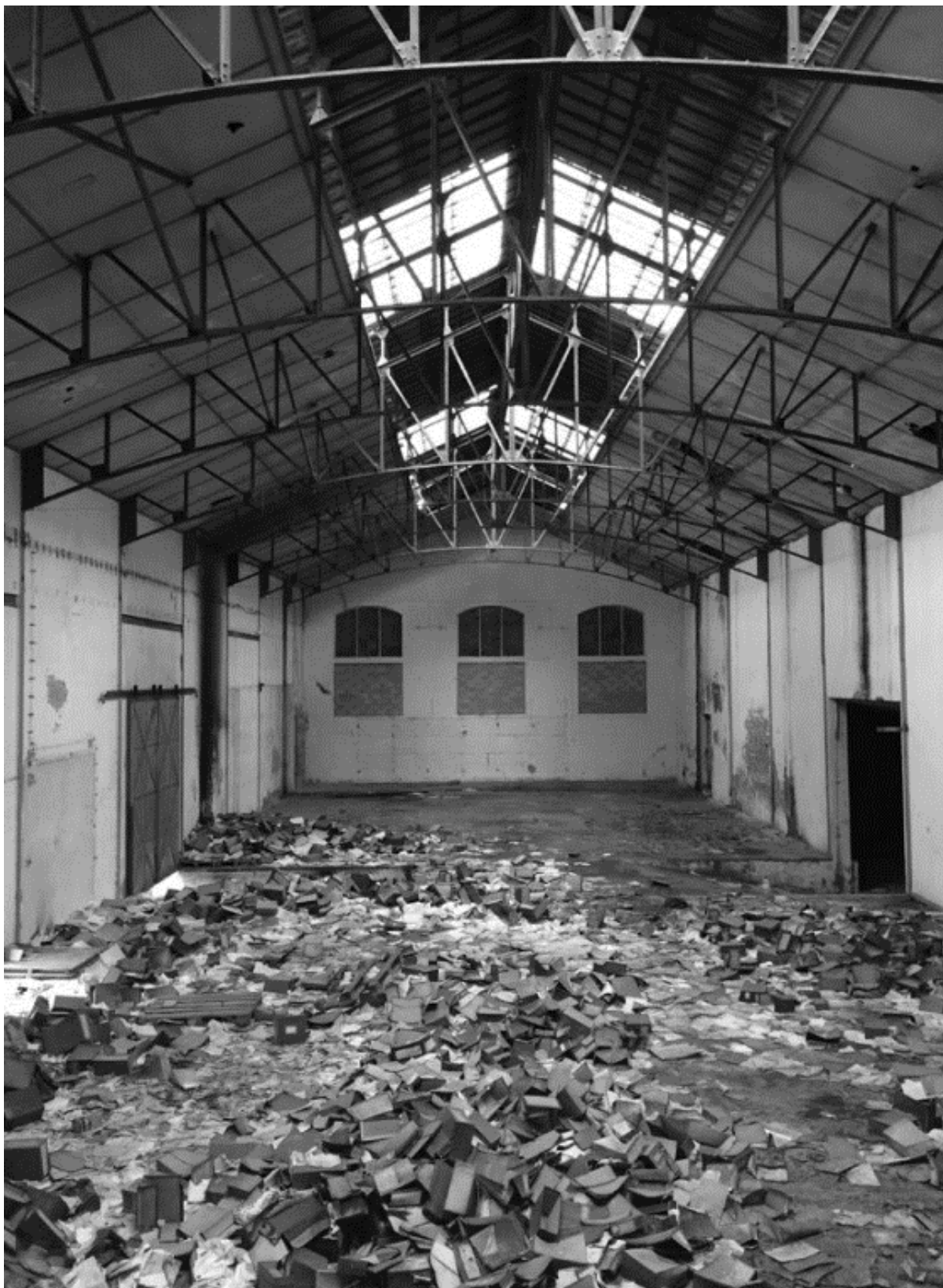
Imagem 7: Vista do interior da galeria da Fábrica do Gás, (in Fernando Miranda 2016).
