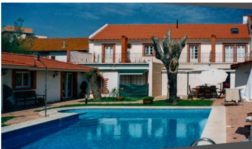
Alçado posterior, após a intervenção, Bairro Batista, Setúbal
