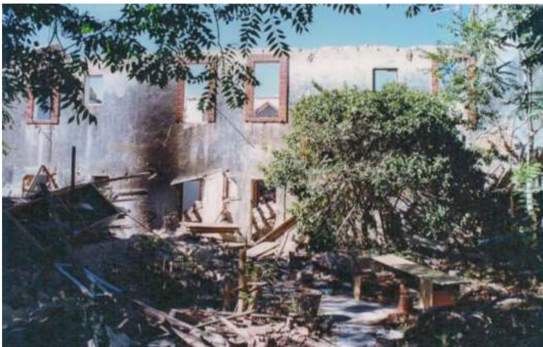
Alçado posterior, antes da intervenção Bairro Batista, Setúbal
