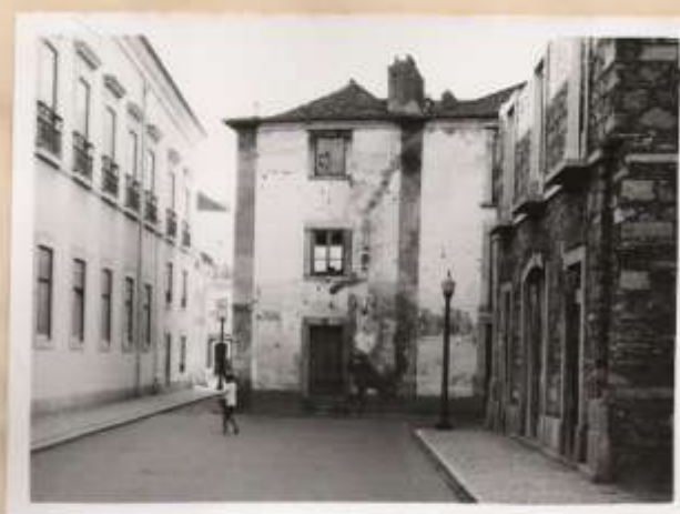
FOTO.2 Travessa do Paço (prédio em ruínas ladeando o edifício da Câmara Municipal)
