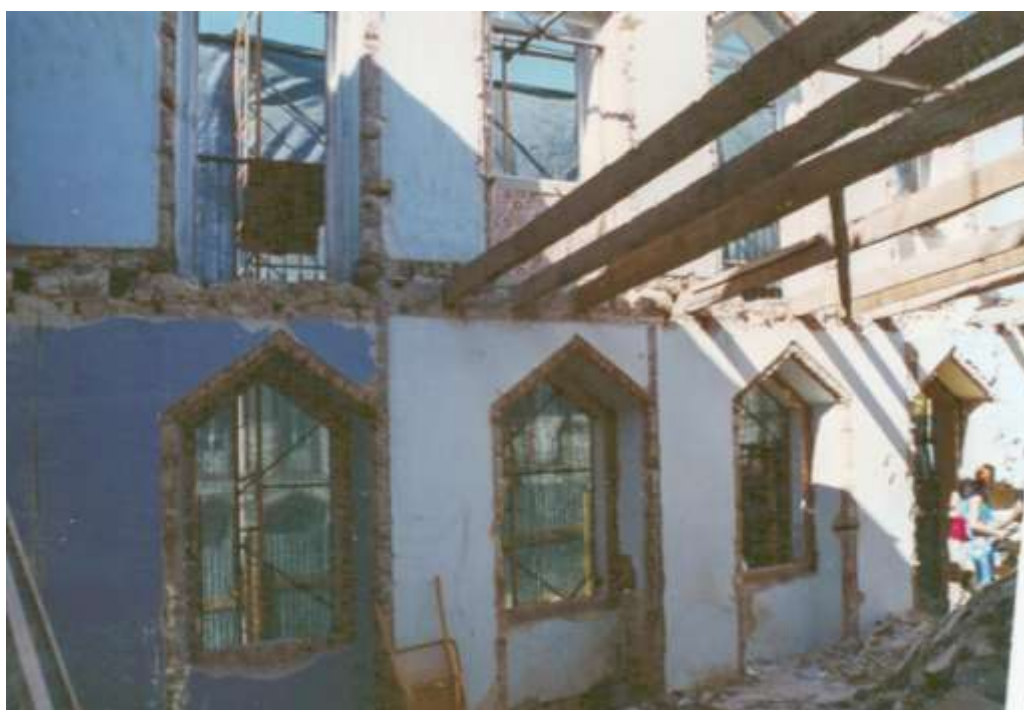
Interior da habitação durante a intervenção, Bairro Batista, Setúbal
