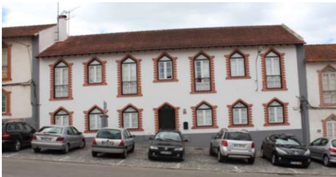
Fachada Principal após a intervenção, Bairro Batista, Setúbal
