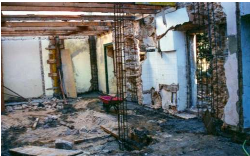
Interior da habitação durante a intervenção, Bairro Batista, Setúbal
