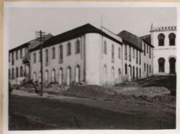
FOTO.22 Aspecto de edifícios que ladeiam a Praça de Touros.
