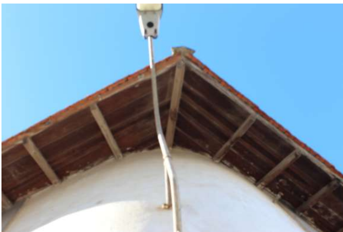
Sistema construtivo, acabamento do beirado, Bairro Batista, Setúbal – 2018
