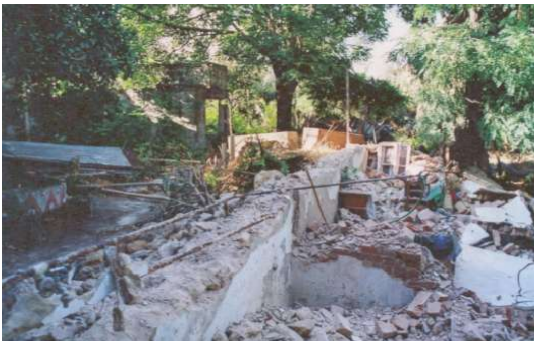
Logradouro antes da intervenção, Bairro Batista, Setúbal
