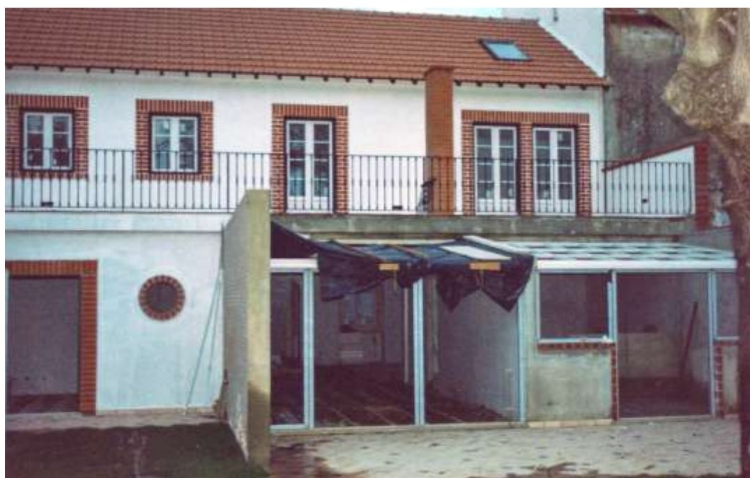
Alçado posterior durante a intervenção, Bairro Batista, Setúbal
