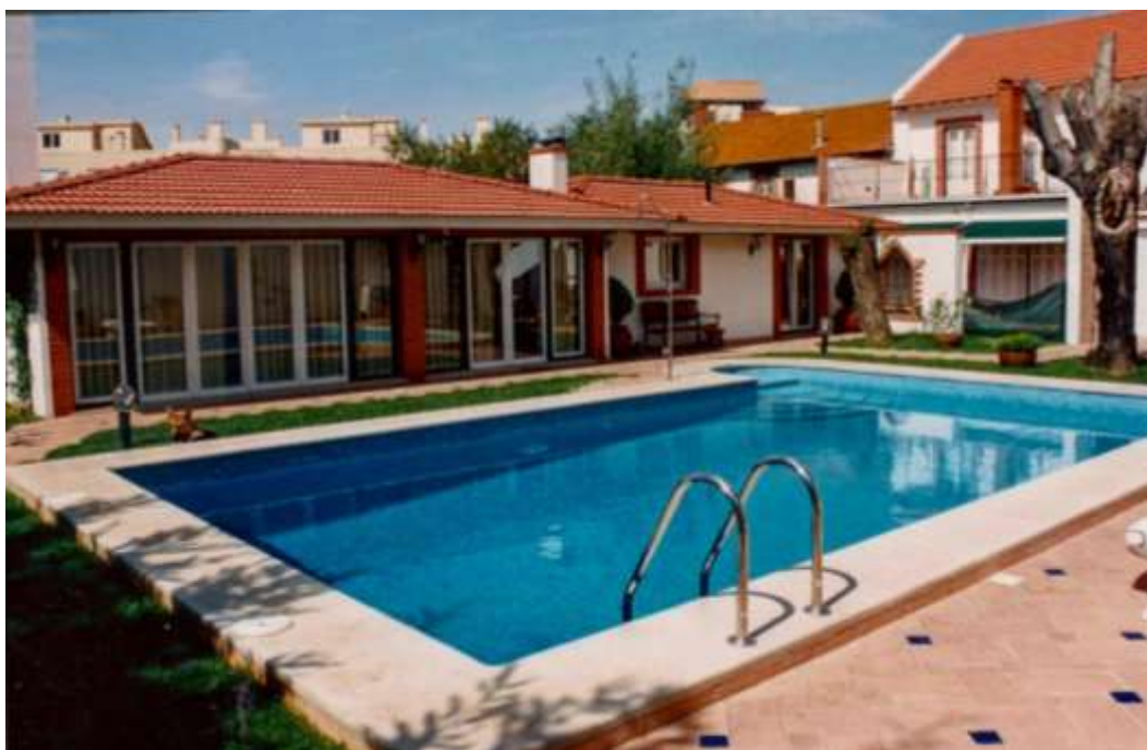
Logradouro após a intervenção, Bairro Batista, Setúbal
