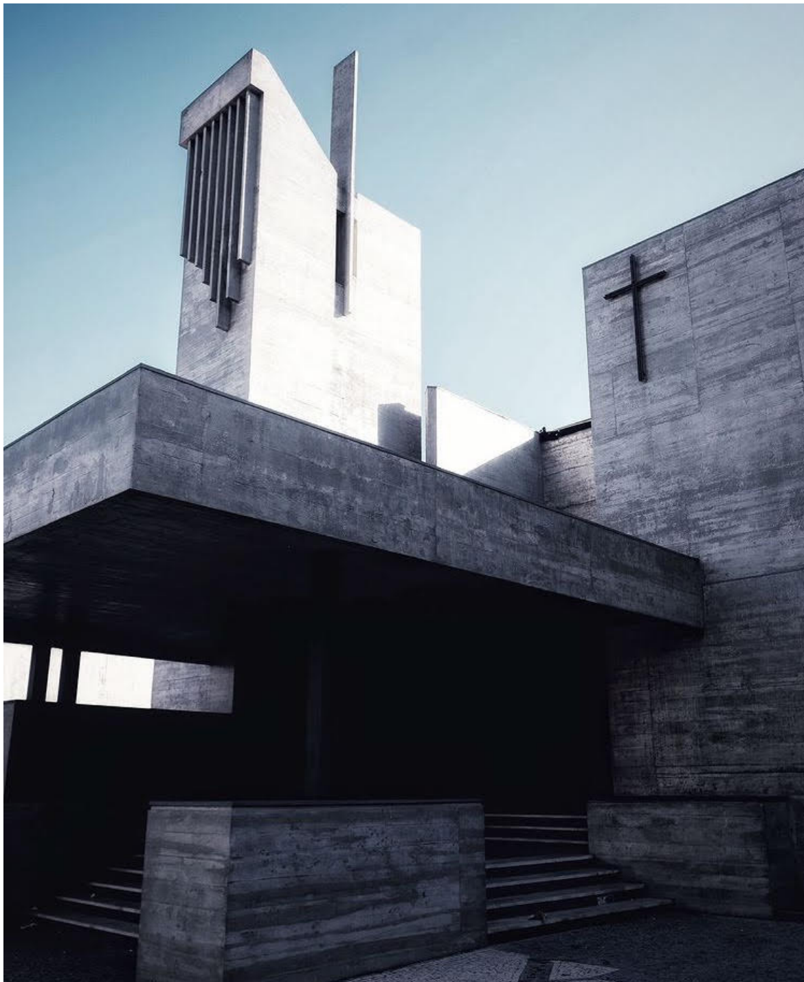
FIGURA 17 - Igreja da Paróquia de N.ª S.ª da Boavista (1974-1999), também conhecida como Igreja do Foco, com projeto do arquiteto Agostinho Ricca, Porto.
