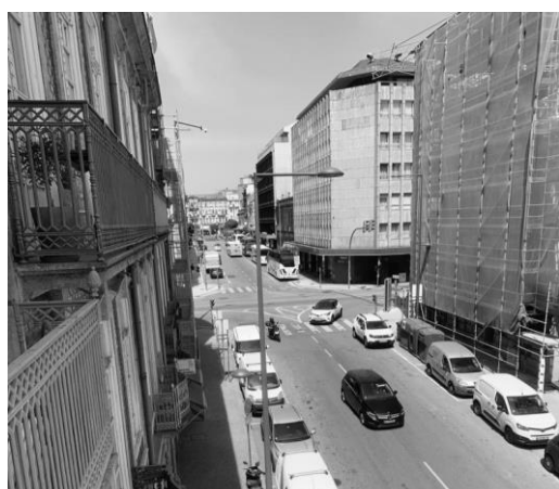
Figura 22 - Rua Alexandre Herculano/ Vista para a Batalha
